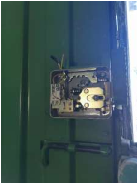
Figura 40. Instalación de la cerradura eléctrica
