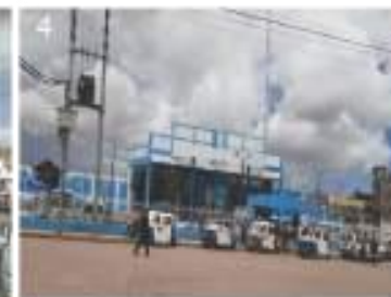
Figura 43. Terminal Terrestre. Fuente: Elaboración propia.
