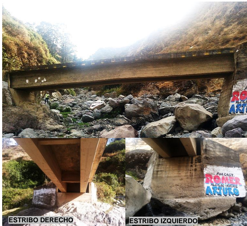
Fig. 2: Visualización general de la estructura (Puente KM 14+229.87) Fuente: Elaboración propia
