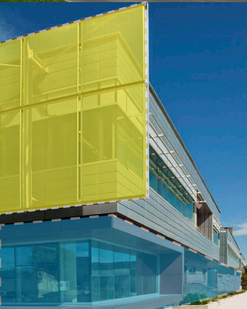
Figura 98. Vista de la protección solar de acero perforado de la fachada
