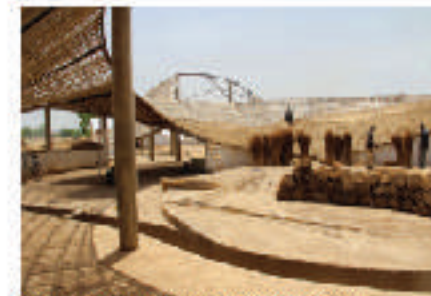
Figura 5.22 Vista de estructura del proyecto Fuente: Arellano, 2019
