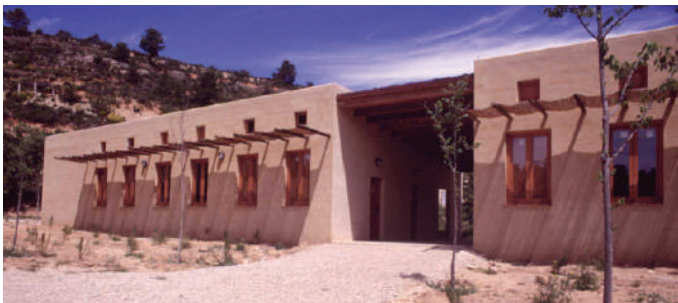
Figura 5.28 Vista del bloque B Fuente: Elaboración propia, 2019
