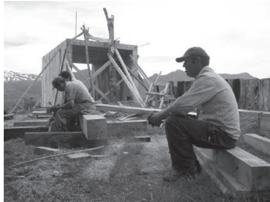
Figura 2.4: Mirador de Pinohuacho en construcción Fuente: Archdayli Perú
