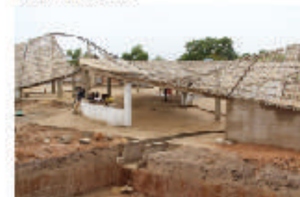
Figura 5.23 Vista de estructura del proyecto Fuente: Arellano, 2019
