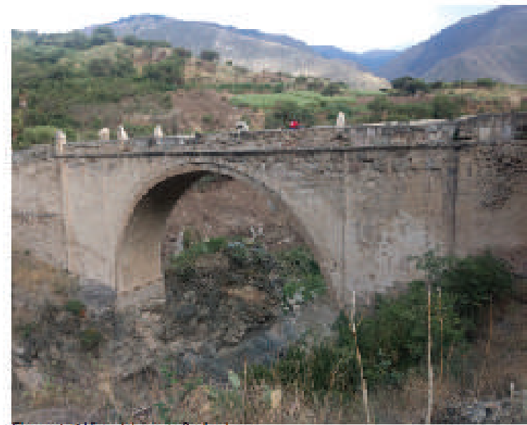
Figura 4.42 Vista del puente Pachachaca. Fuente: Arriola Rojas, 2019
