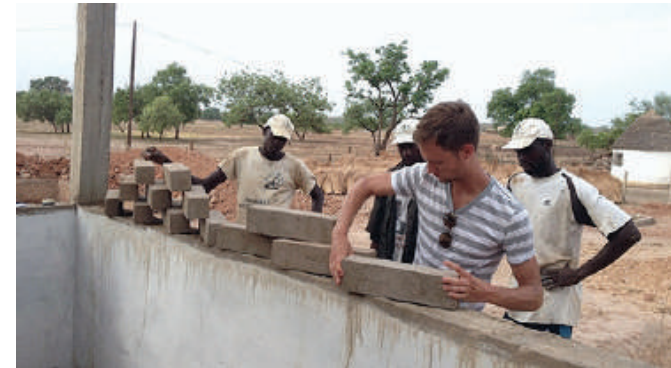
Figura 5.26 Colocación de bloques en muros Fuente: Arquine, 2015
