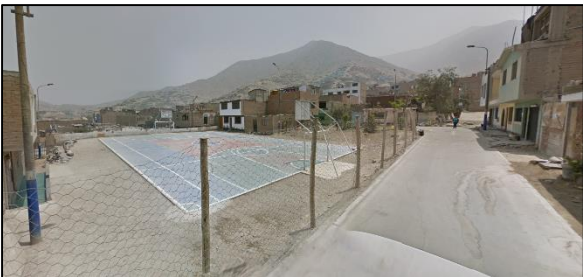
Imagen 16: Losa deportiva de la zona C. Fuente: Propia.
