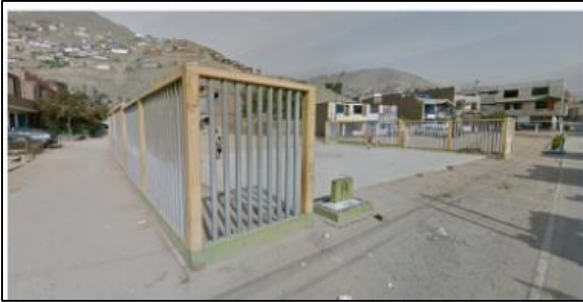
Imagen 11: Losa deportiva de la zona C. Fuente: Propia.
