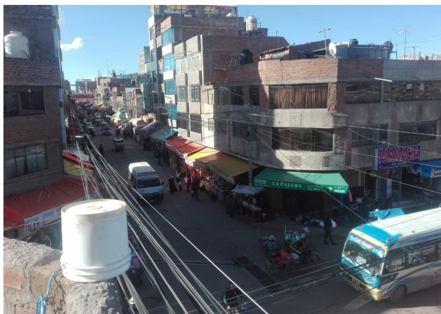
Foto 4. Instalaciones de sensores en nodo 1
