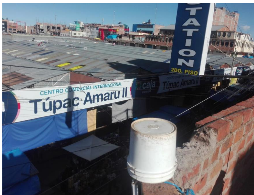
Foto 3. Instalaciones de sensores en nodos- Mercado Tupac Amaru
