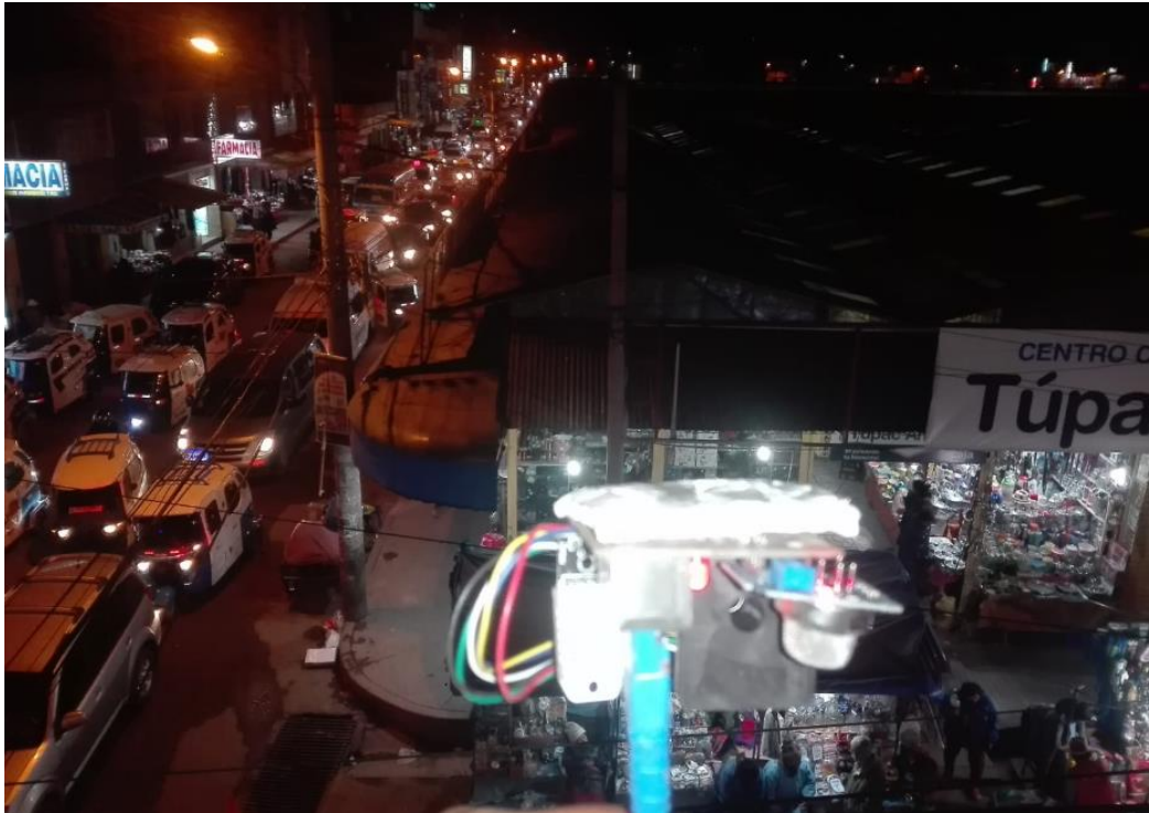
Foto 5. Instalaciones de sensores
