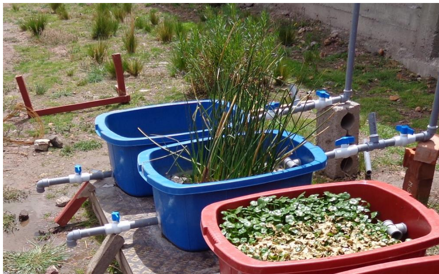
Figura 29. Lechos de humedales artificiales
