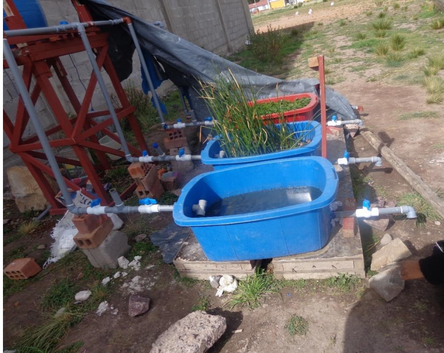
Figura 30. Instalación de Humedales Artificiales
