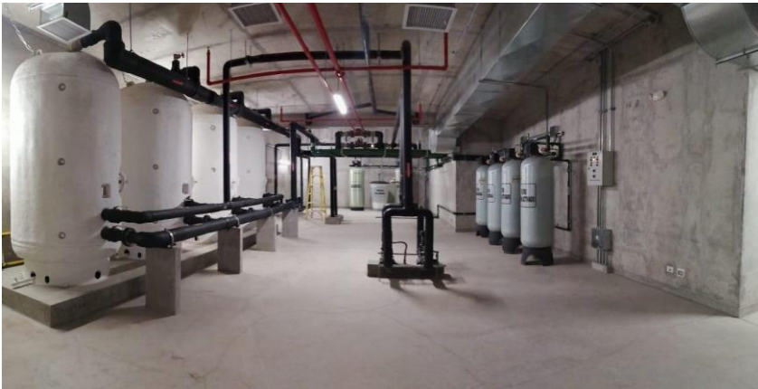
Figura N° 23: Distribución de las cisternas
