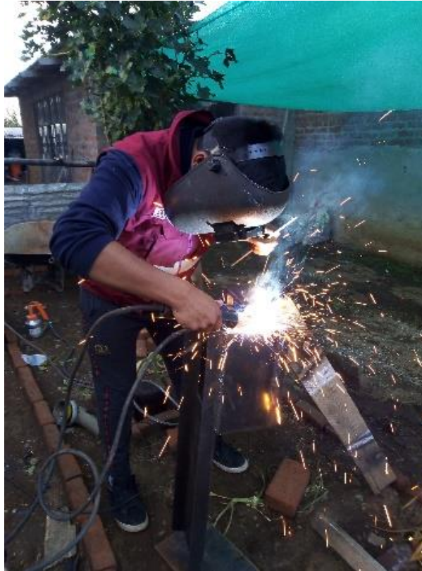
Fotografía 3. Se realiza el quemado completo con soldadura eléctrica.
