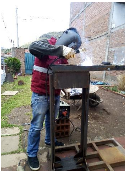
Fotografía 2. Armado y punteado de los perfiles de acero que han sido cortados.
