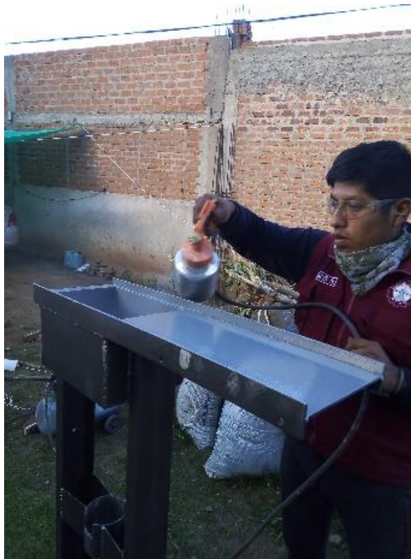
Fotografía 12. Pintado de base acrílica color gris claro a la estructura de metal.
