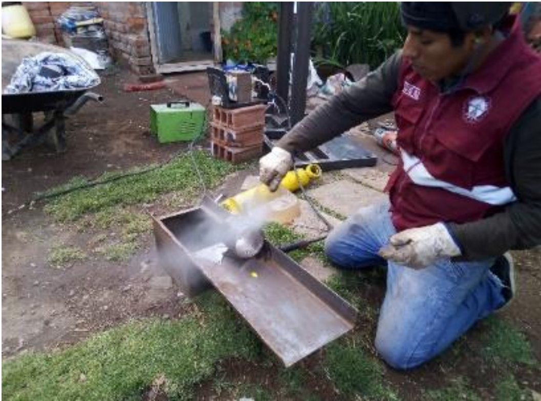
Fotografía 7. Construcción de la caja de alimentación móvil.
