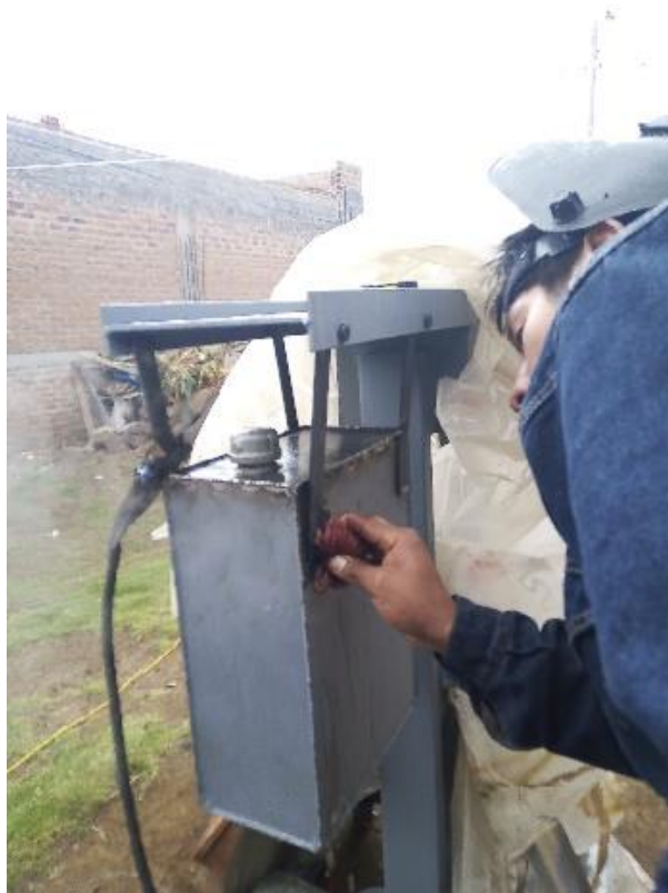
Fotografía 5. Construcción del depósito de hidrolina.
