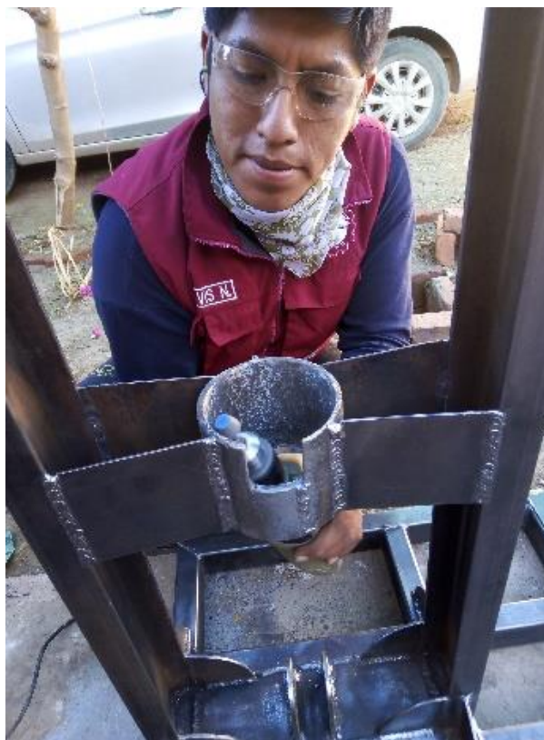
Fotografía 9. Construcción del soporte metálico para el cilindro hidráulico.
