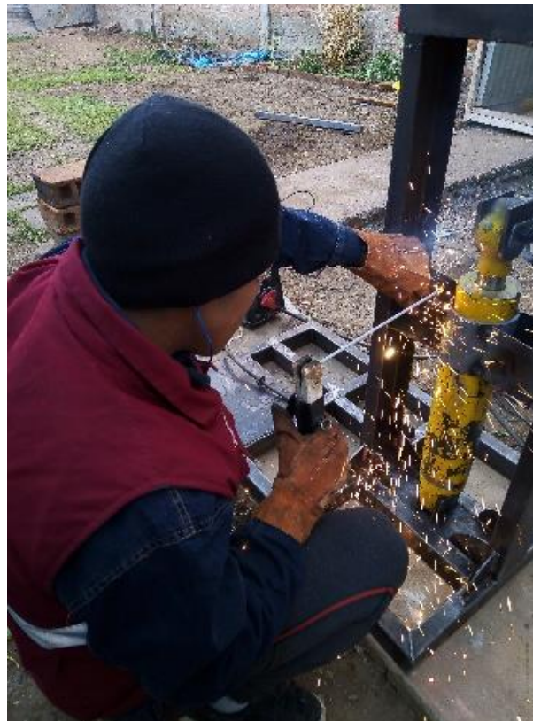
Fotografía 4. Instalación del Cilindro Hidráulico.
