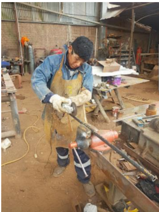
Fotografía 1. Se realiza los cortes respectivos de los perfiles de acero.
