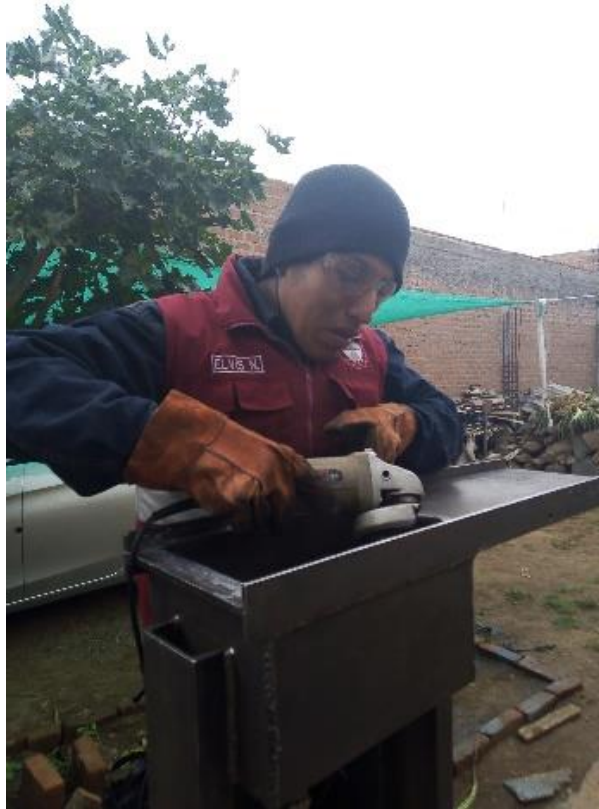
Fotografía 11. Limpieza completa de óxidos con el esmeril portátil y escobillas de acero.
