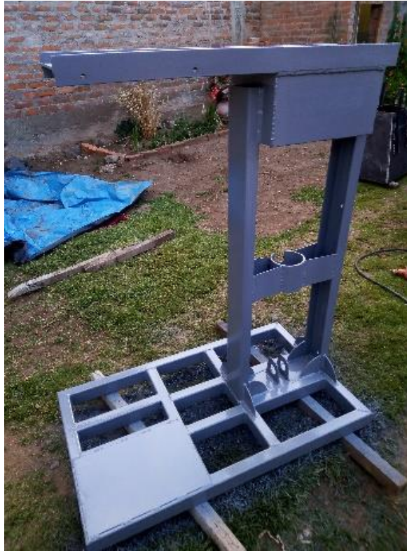
Fotografía 13. Estructura metálica luego de ser pintada con la pintura base anticorrosiva.
