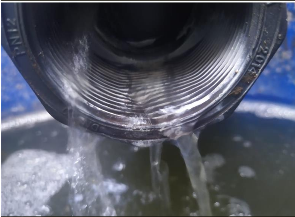
Anexo 31: Vista de la salida del agua residual doméstica tratada del filtro percolador.
