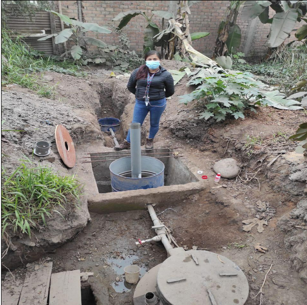
Figura 15: Filtro percolador implementado.
