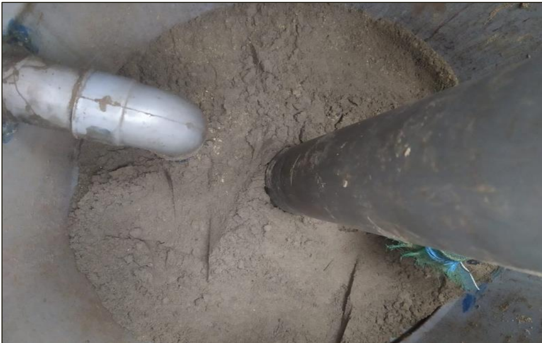
Anexo 29: Preparación de aserrín de madera y arena fina como última capa de empaque del filtro percolador.
