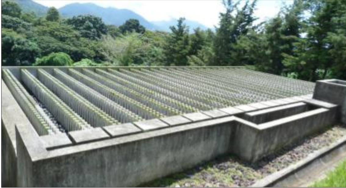
Figura 5: Filtro percolador rectangular, alimentado por gravedad, con distribución fija (C. Castro, 2017, pág. 4).
