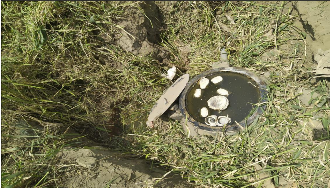
Figura 12: Biodigestor en funcionamiento
