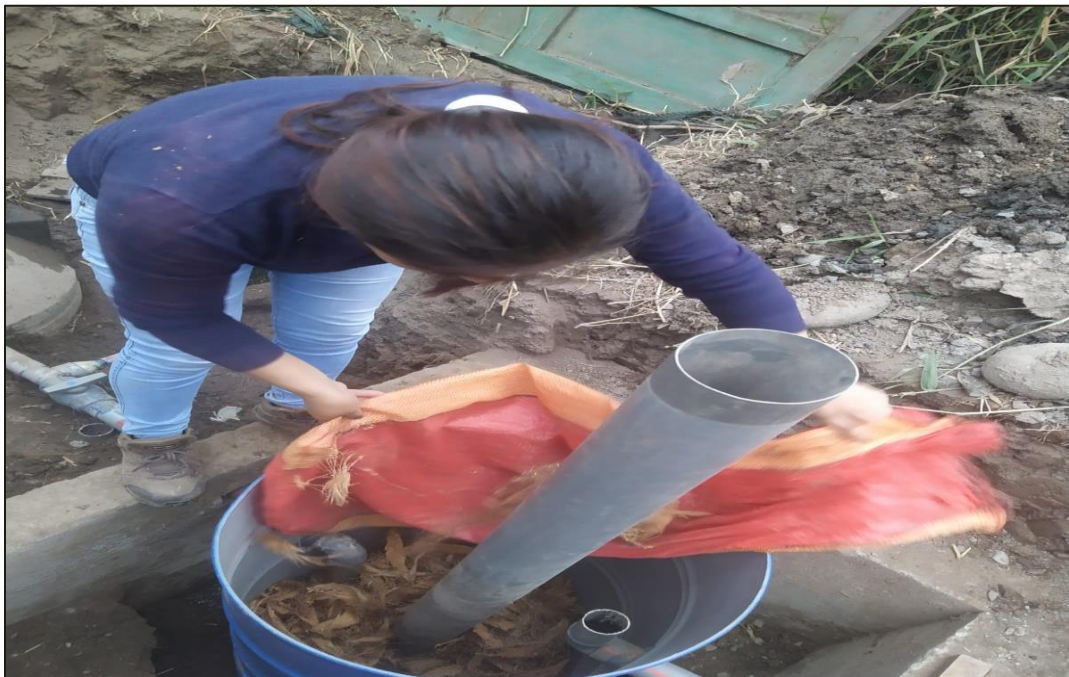
Anexo 28: Preparación e incorporación de fibra de coco como empaque del filtro percolador.
