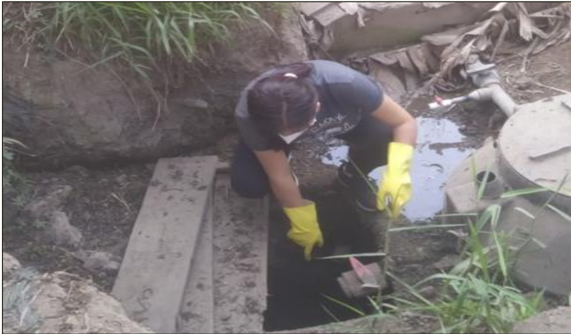
Anexo 32: Vista de la cámara de lodos.
