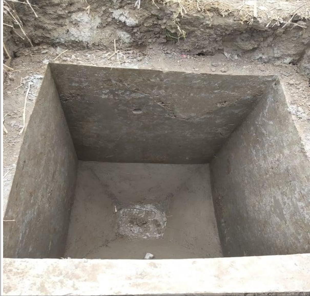
Figura 13: Tanque de concreto de 1500 l de volumen.
