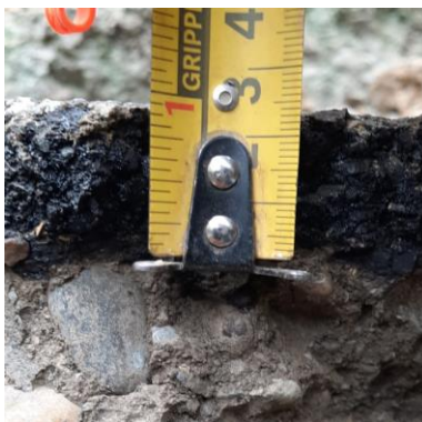
Figura 15. Espesor de la carpeta asfáltica
