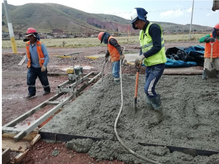
Figura 27. Vibrado del concreto con equipo manual
