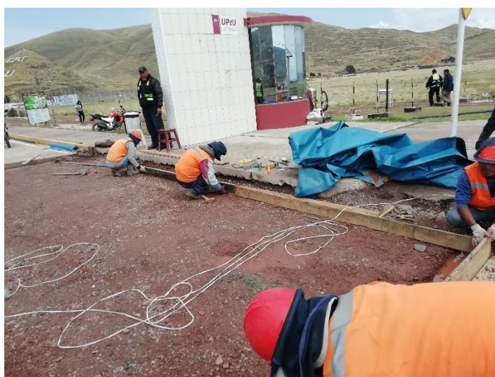
Figura 24. Encofrado de los paños del pavimento h: 13cm
