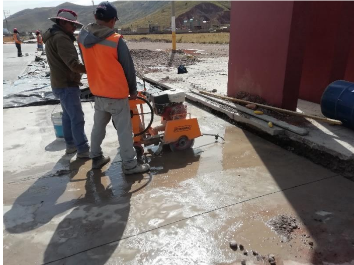
Figura 30. Corte de juntas después de 20 horas.
