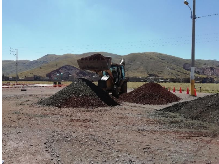
Figura 20. Batido de material granular para subbase
