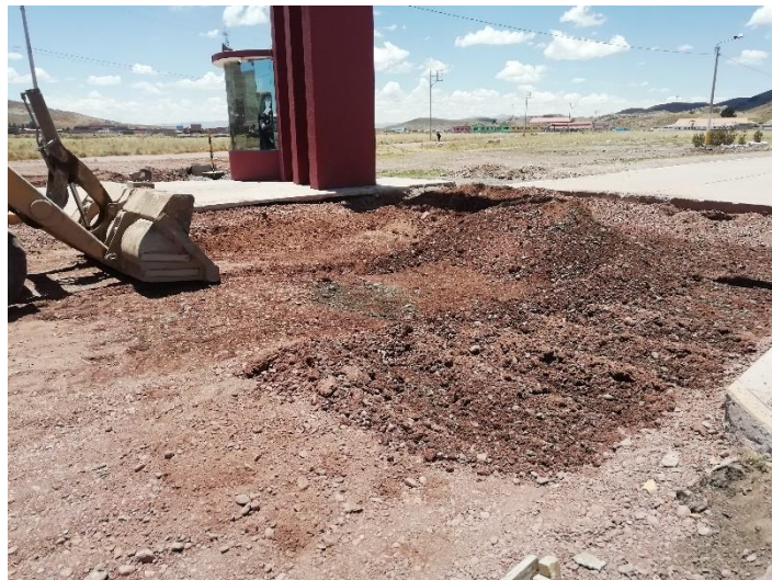
Figura 21. Extendido del material de subbase en todo el ancho de la vía
