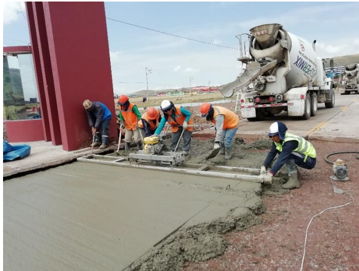
Figura 28. Regleado de paño de concreto con equipo
