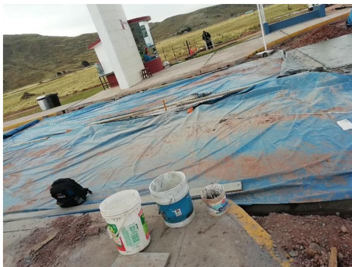
Figura 31. Curado del pavimento
