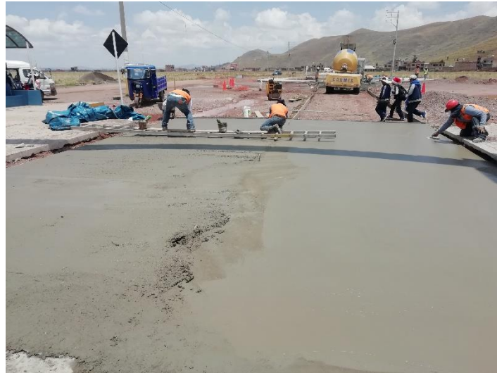
Figura 29. Acabado con plancha metálica
