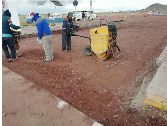
Figura 22. Compactación de subbase con rodillo vibratorio, y apisonador mecánico
