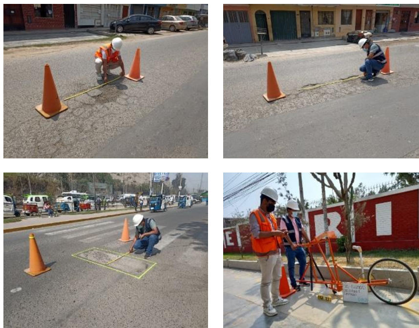
Fig. 2. MATERIALES UTILIZADOS PARA LA FASE DE CAMPO, CONOS DE SEGURIDAD Y LOS EQUIPOS FLEXÓMETROS Y RUGOSÍMETRO DE MERLÍN
