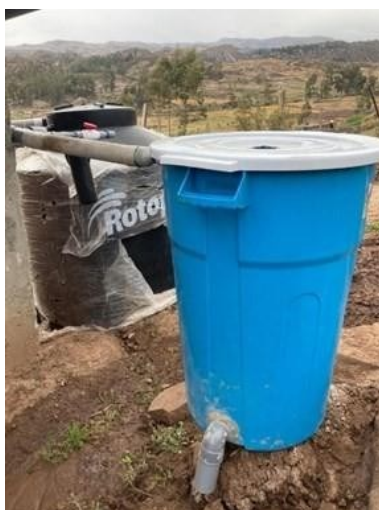
Figura 13. Interceptor de primeras aguas Fuente: Elaboración Propia
