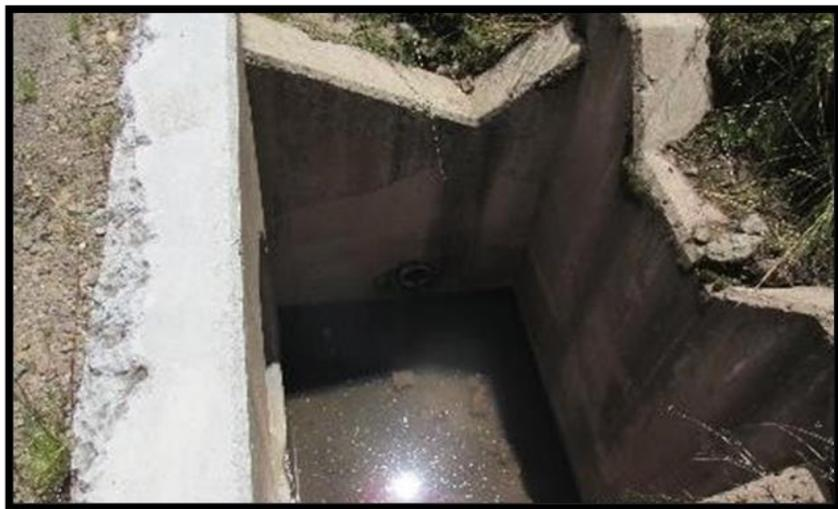
Figura 05. Cabezal de entrada, obstruido.
