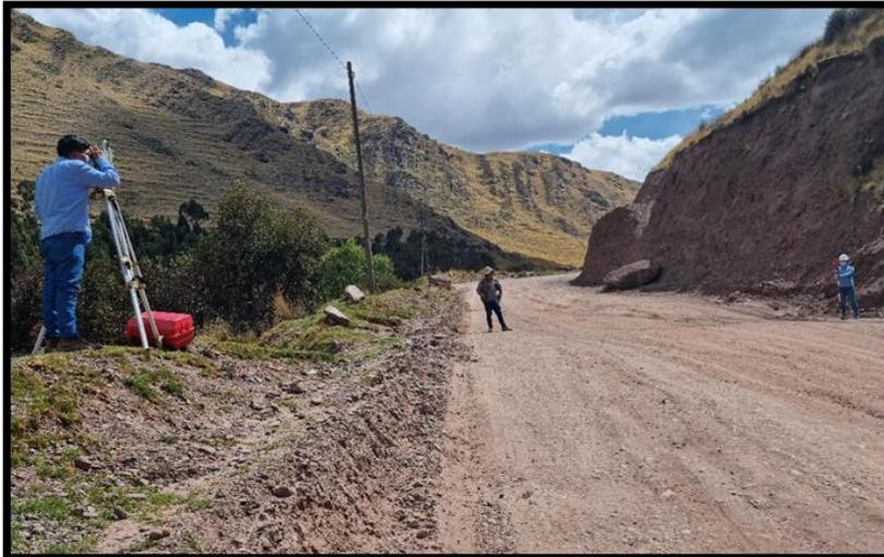
Figura 01. Estimación del borde lado derecho de la carretera sin asfaltar.
