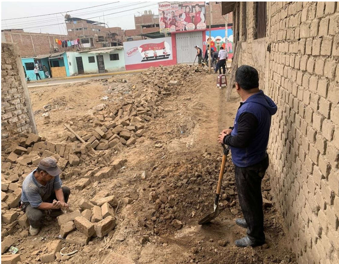
Figura 14: excavación de bases y preparación de columnas
