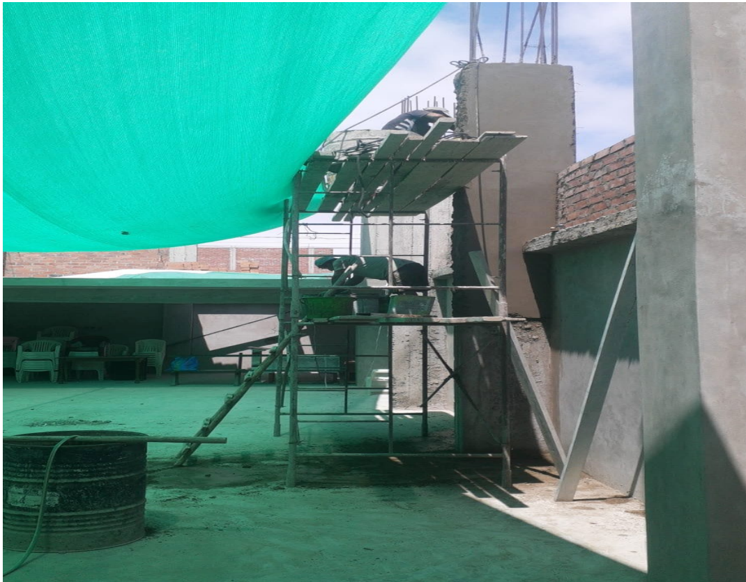
Figura 17: templo de "Monte Sinai" en construcción
