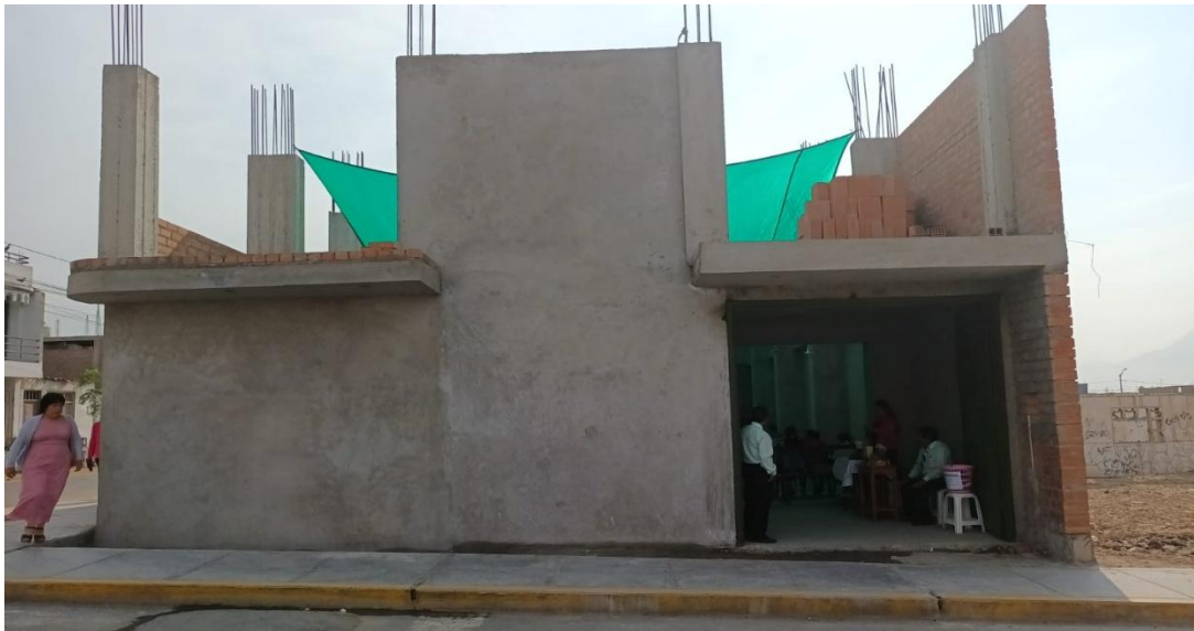
Figura 18: frontis del templo “Monte Sinai” en construcción
