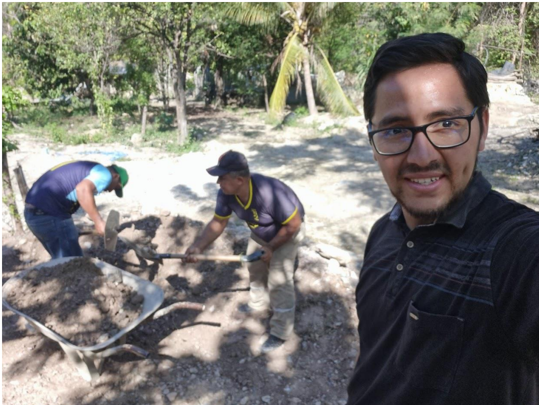
Nivelado de piso Vijus
