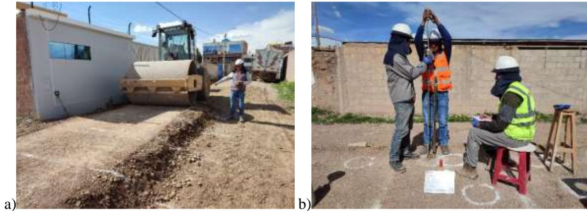
**Figura 7.** a) Compactación del relleno de pruebas con rodillo, b) prueba de DCP. Fuente: el autor
