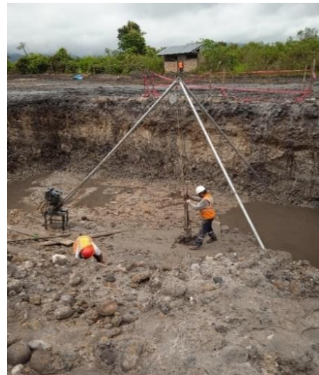
Fig. 5. Ensayo de SPT en el área de excavación. Fuente: Elaboración propia.
