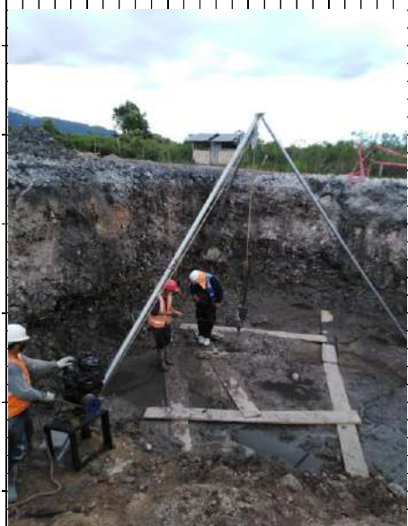
PERFORACIÓN DE SONDEO S-02
