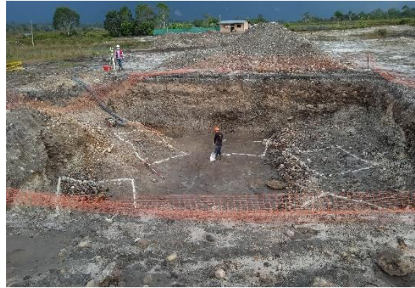
Fig. 4. Excavación masiva de la zona de estudio. Fuente: Elaboración propia.
