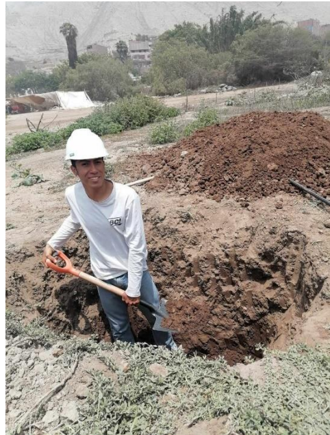
Figura 10. Elaboración de Calicatas Fuente: Elaboración propia
