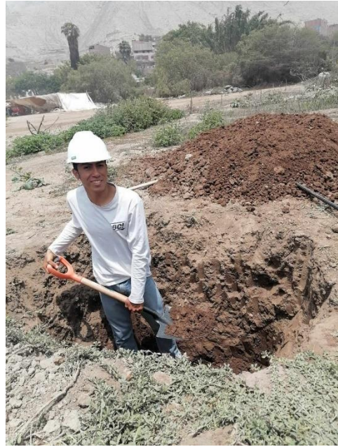
Figura 10. Elaboración de Calicatas Fuente: Elaboración propia
