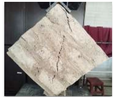
Figura. 14. Falla por tensión diagonal en bloques (adobe-cal al 20%).
