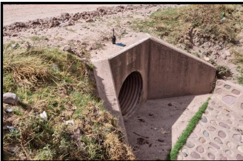
Figura 03. Ubicación de cabezal de salida, alcantarilla de alivio.
