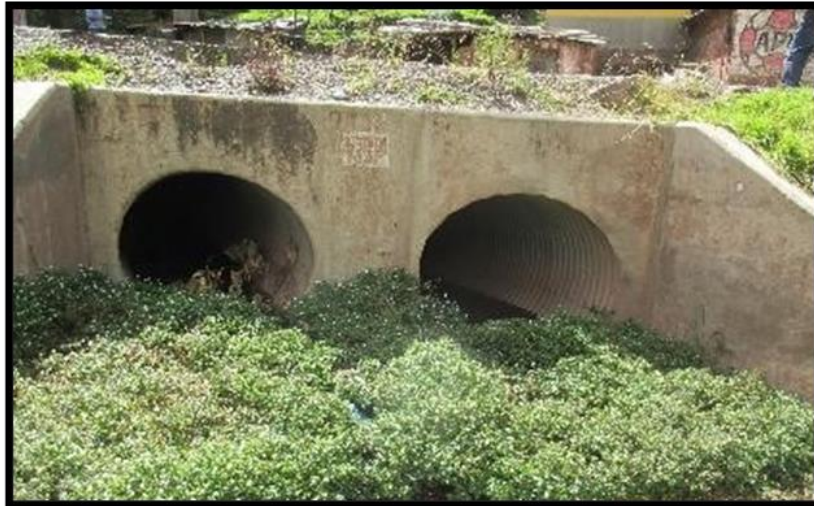
Figura 07. Ubicación cabezal de salida, alcantarilla de quebrada o paso.
