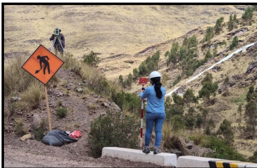
Figura 06. Ubicación de cabezal de salida, alcantarilla de alivio.
