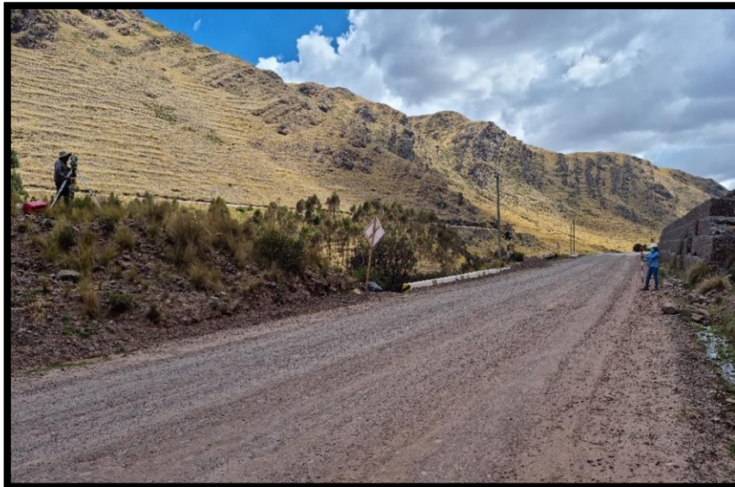
Figura 08. Estado de conservación de la carretera en estudio.
