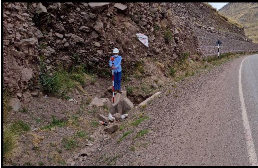
Figura 04. Ubicación de cabezal de entrada, alcantarilla de alivio.
