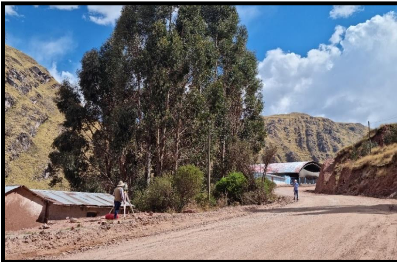
Figura 02. Estimación del borde lado izquierdo de la carretera sin asfaltar.
