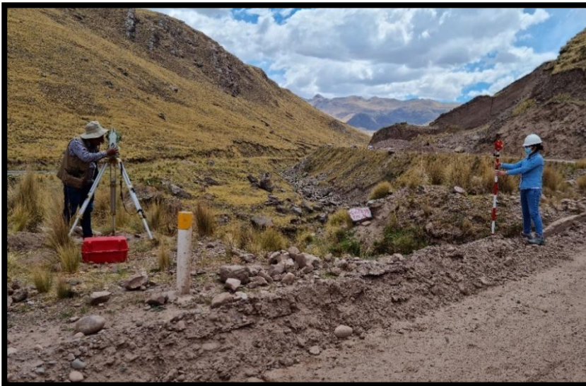
Figura 11. Ubicación de cabezal de salida, alcantarilla de alivio.
