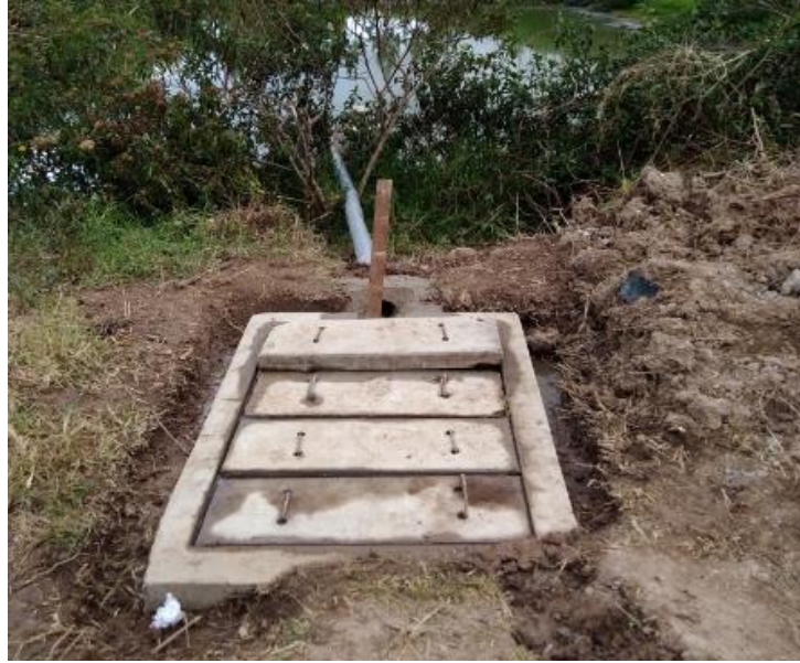
Figura 13. Tubería que devuelve el caudal a la PTAR
