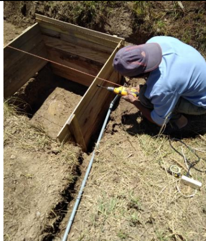
Foto 31. Perforación para ingreso de tubería que traslada el afluente
