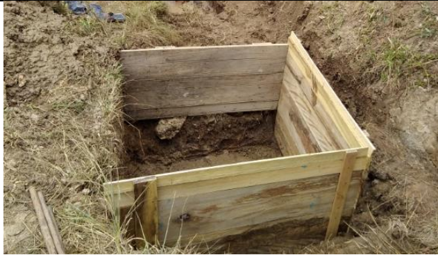
Foto 28. Excavación del tanque sedimentador
