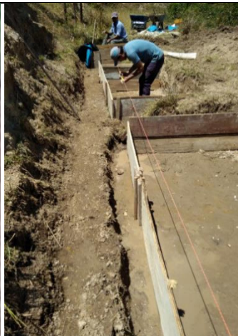
Foto 37. Nivelación de la infraestructura y determinación de la pendiente del agua
