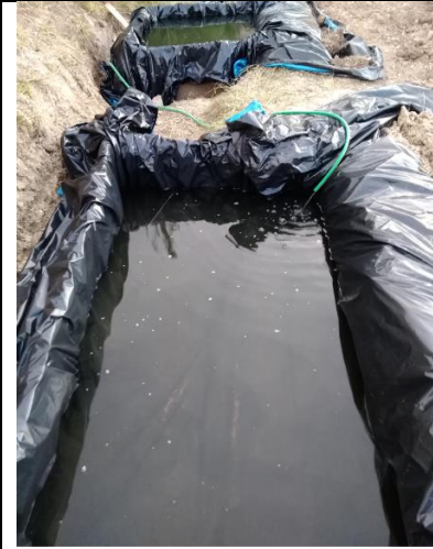
Foto 38. Prueba hidrostática del humedal
