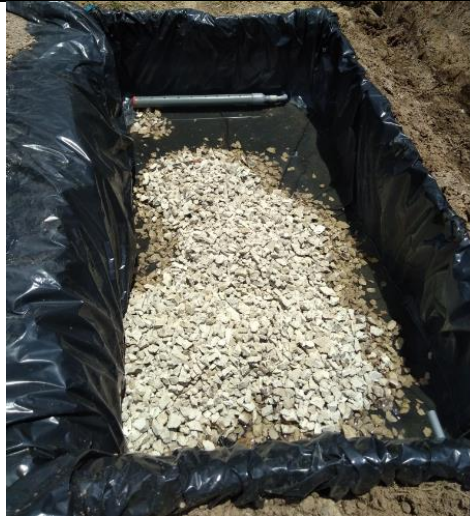
Foto 39. Instalación de la tubería de recolección.
