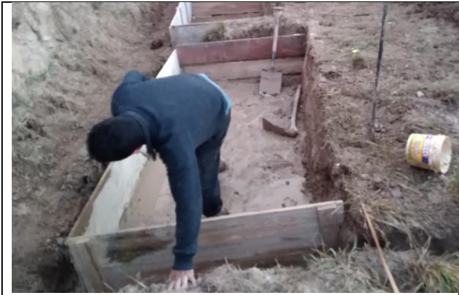
Foto 48. Montaje del humedal superficial
