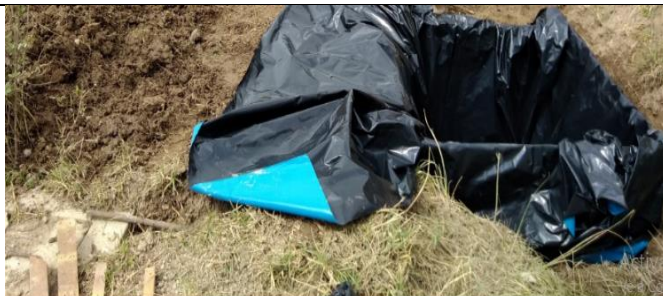
Foto 30. Infraestructura de soporte para la impermeabilización y laguna anaerobia
