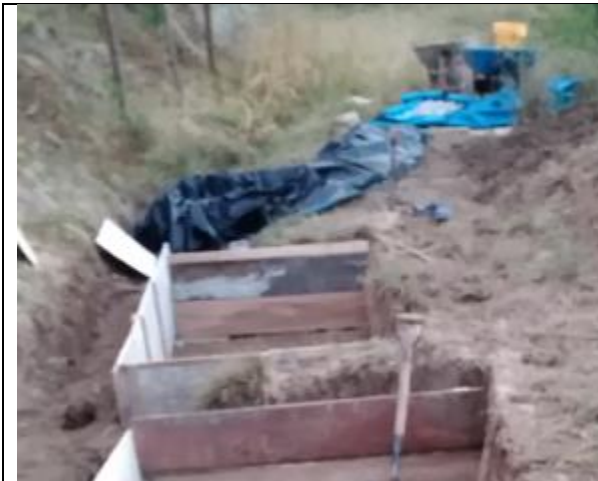
Foto 36. Excavación del Humedal y colocación de la infraestructura de soporte.
