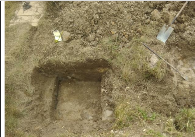
Foto 28. Excavación del tanque sedimentador
