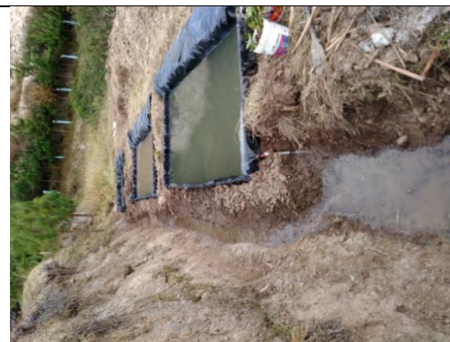
Foto 51. Prueba hidrostática del humedal de flujo superficial
