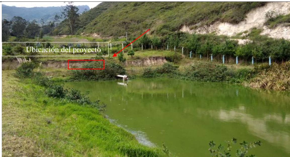
Foto 25. 1ra Laguna de estabilización para tratamiento primario
