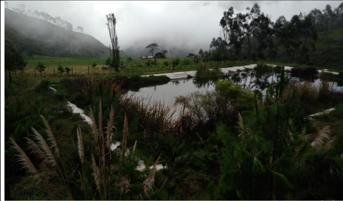
Foto 26. 2da Laguna de estabilización para tratamiento secundario
