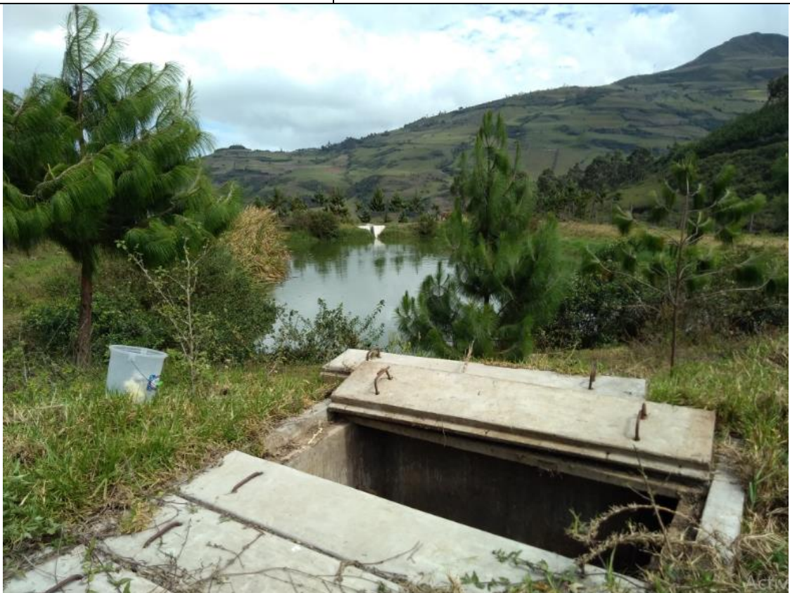
Foto 3. Vista panorámica de la cámara de rejillas
