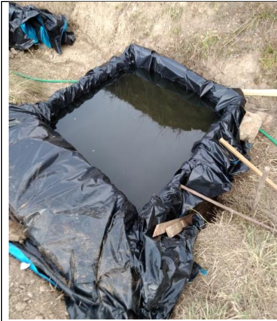
Foto 34. Finalización de prueba hidrostática
