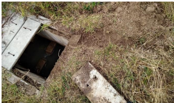
Figura 12. Caja de vertedero y punto de captación
