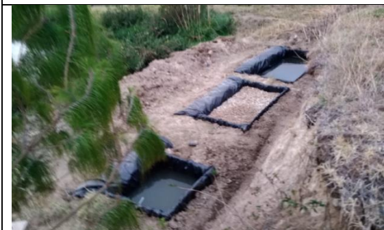
Foto 50. Colocación de doble capa de plástico para la infiltración
