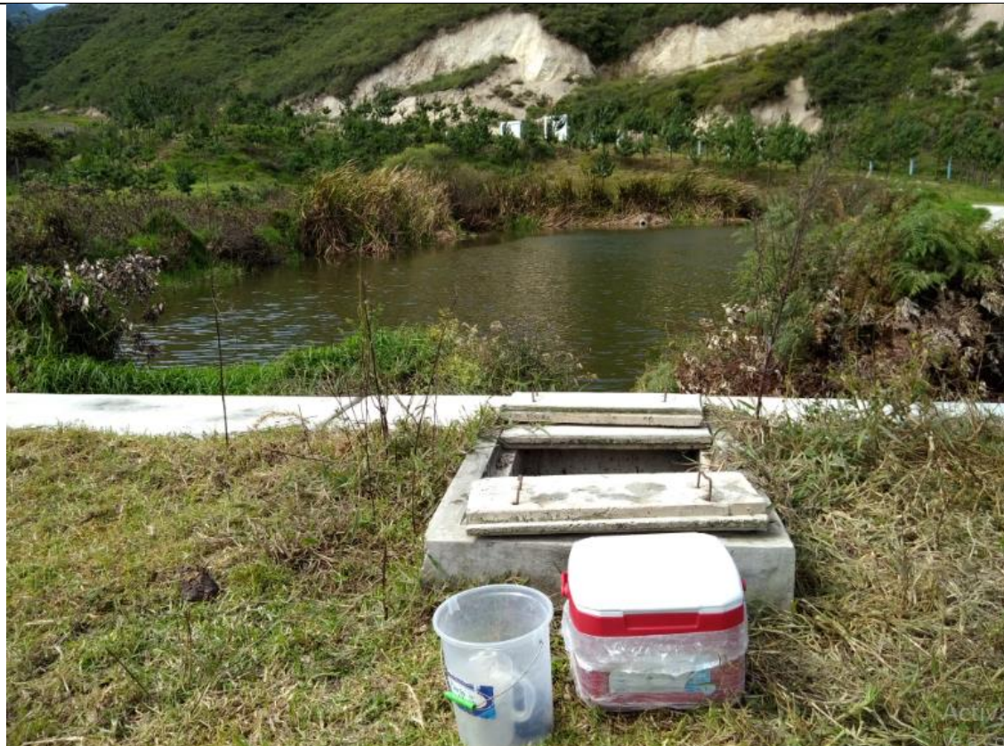
Foto 26. 2da Laguna de estabilización para tratamiento secundario
