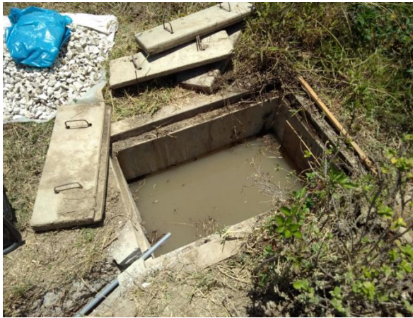
Foto 10. Inicio del llenado de la captación
