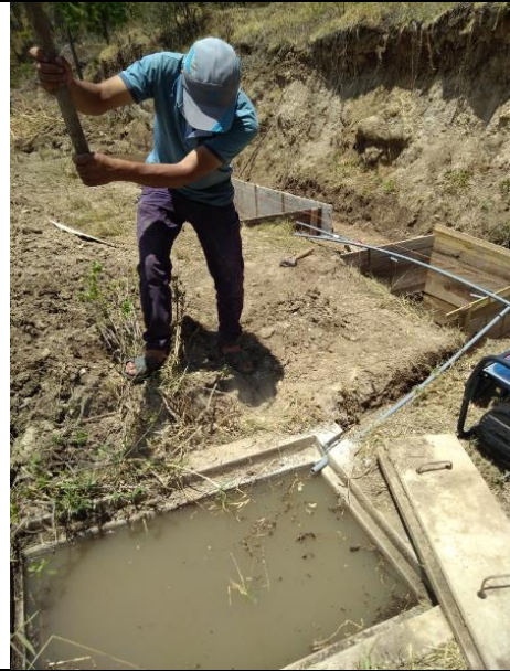
Foto 11. Llenado de captación
