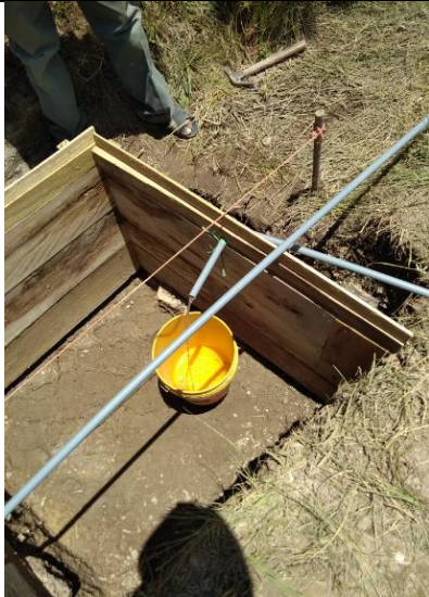
Foto 12. Verificación de pendiente y conducción del afluente
