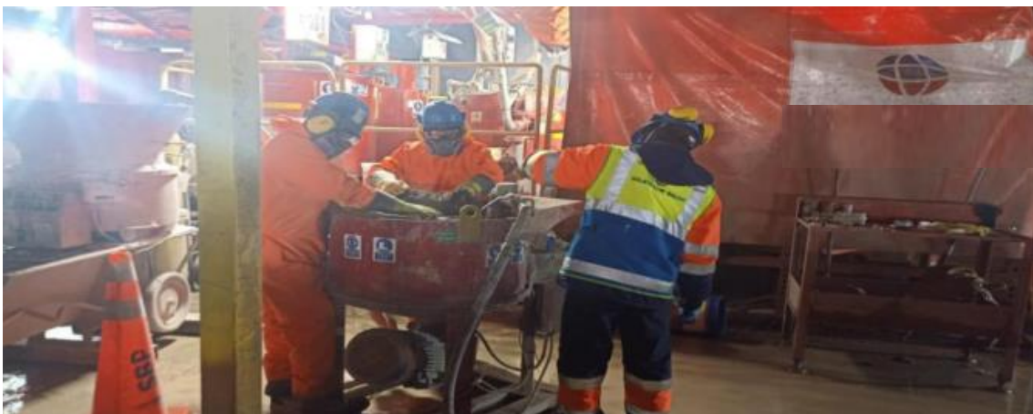
Figura 56: Proyecto 02; proceso de preparación de mortero para relleno en tramos de concreto plástico y morrena.
