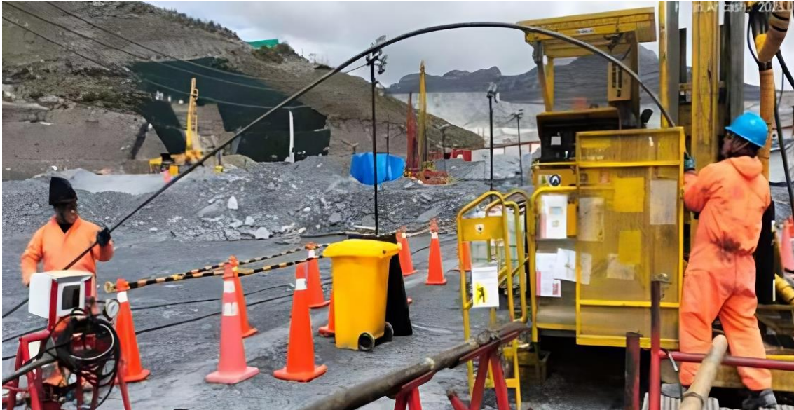
Figura 54: Proyecto 02; medición de nivel freático de agua y profundidad de perforaciones.
