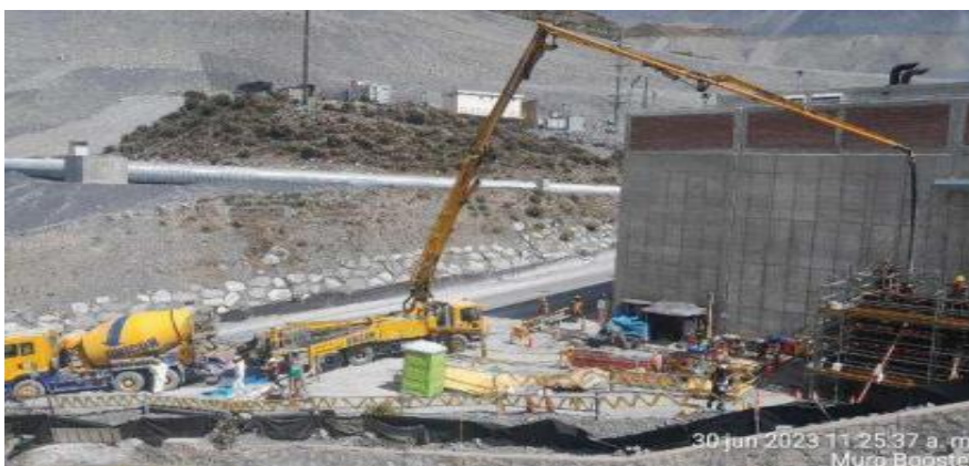
Figura 108: Vaciado de concreto con apoyo de bomba.
