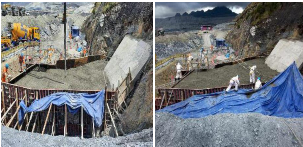
Figura 35: Proyecto 01; vaciado de concreto en plinto de estribo izquierdo.
