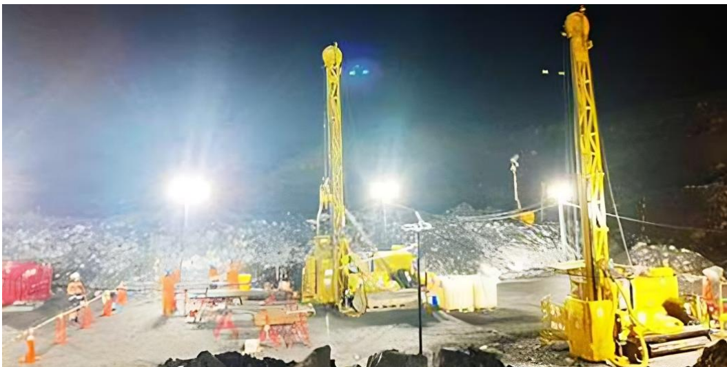
Figura 52: Proyecto 02; trabajos de perforación en turno noche en el frente de Huacacocha 01.
