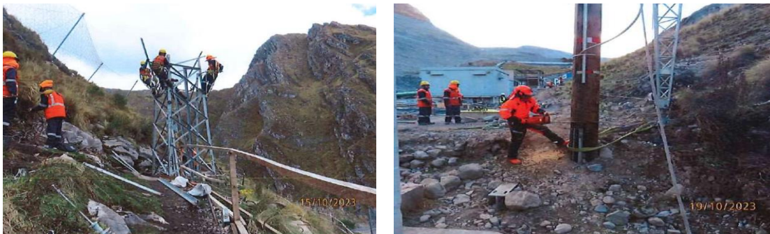
Figura 71: Proyecto 03; desmontaje de torres simples y postes de madera.
