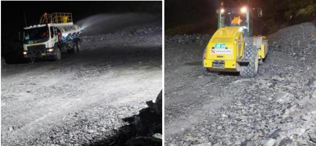
Figura 30: Proyecto 01; regado y compactación de relleno 3b en frente espaldón.
