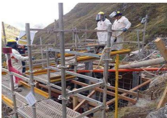
Figura 107: Nivelación de Stub T. 12.39.
