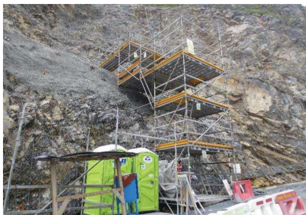
Figura 106: Instalación de andamios para el acceso a las dos estructuras T-28.07/ T-12.38.
