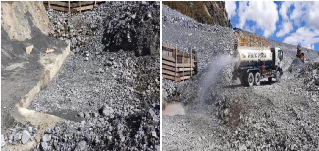
Figura 31: Proyecto 01; avances de trabajo en estribo derecho, concreto en plinto y regado de material de 2b antes de la compactación.
