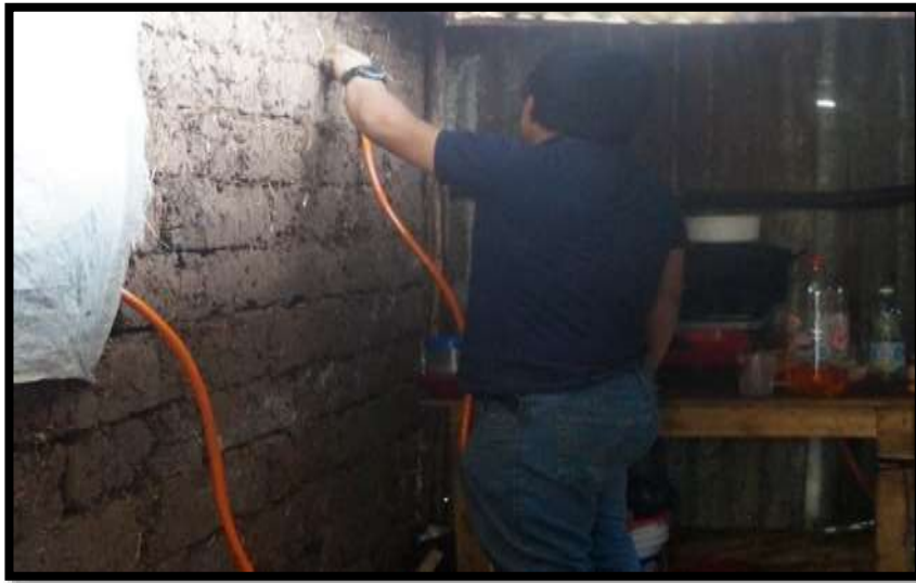
Imagen 37. Instalación de la manguera a la cocina.
