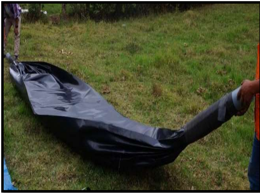
Imagen 31. Instalación del biodigestor.
