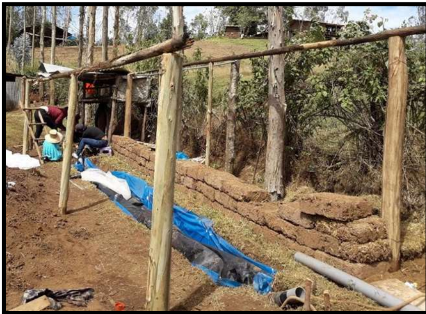
Imagen 35. Construcción de la Caseta
