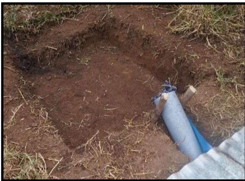
Imagen 32. Nivelación del tubo de entrada.
