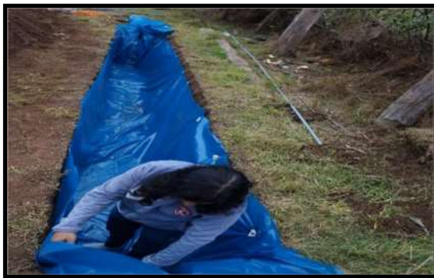
Imagen 30. Acondicionamiento de la zanja
