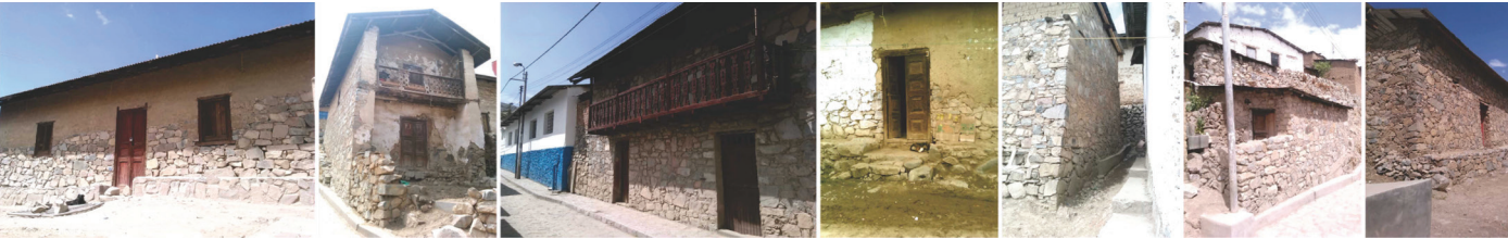
Fotografía 24: Muros de piedra de entorno construido. Archivo Propio.
