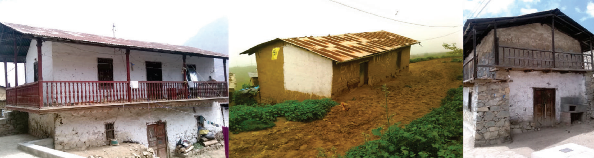
Fotografía 22: Coberturas de entorno construido. Elaboración propia.
