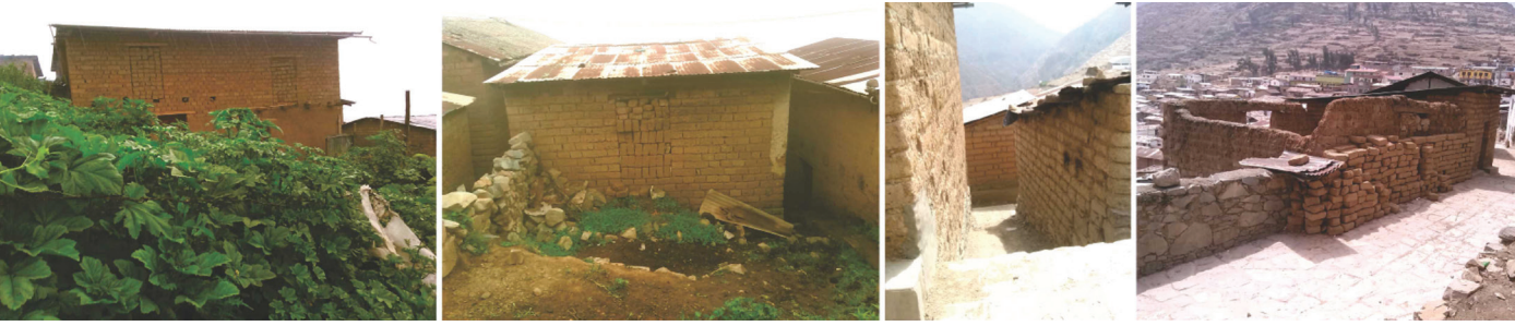
Fotografía 23: Muros de adobe de entorno construido. Archivo Propio.
