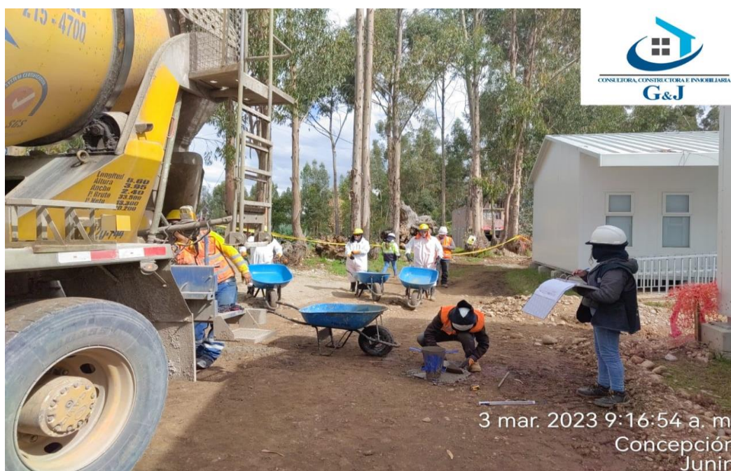
Figura 56: Previo al vaciado se realiza el control de calidad al concreto fresco.
