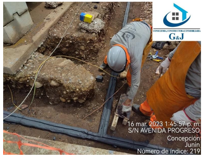
Figura 116: Se aprecia la instalación del cemento conductivo y la realización de soldadura exotérmica para el sistema de puesta a tierra exterior.
