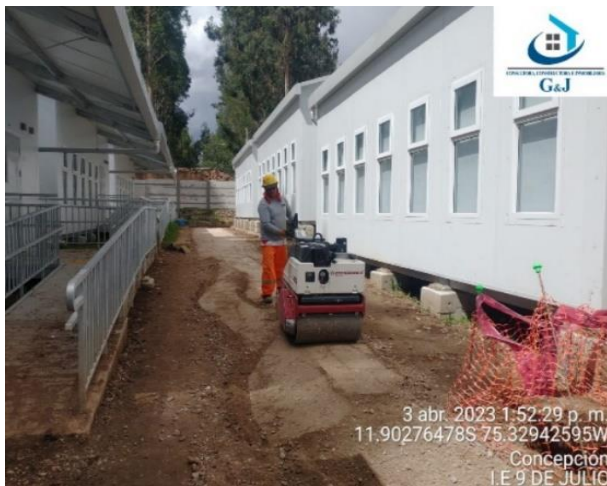
Figura 47: Compactación con el rodillo y ensayo de densidad.
