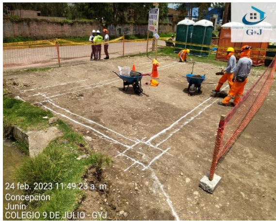
Figura 110: Se realizaron excavaciones manuales para las diferentes estructuras.
