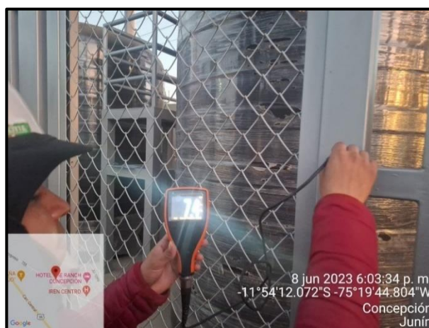
Figura 22: Se muestra la realización de la prueba de adherencia de pintura.
