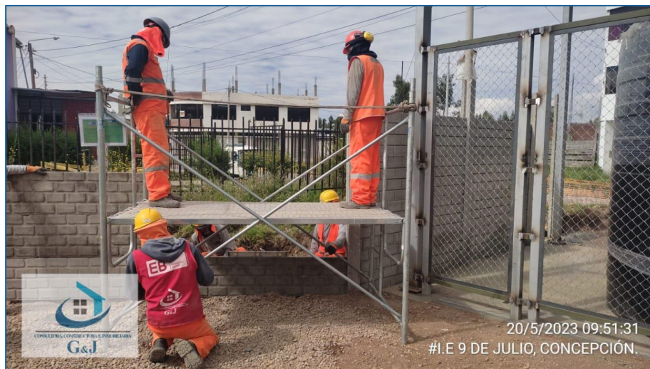
Figura 99: Instalación de placas o paneles prefabricados.
