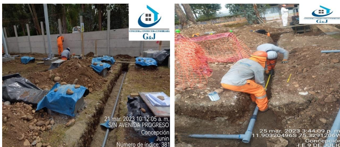
Figura 64: Instalación de tubería de agua en exteriores.
