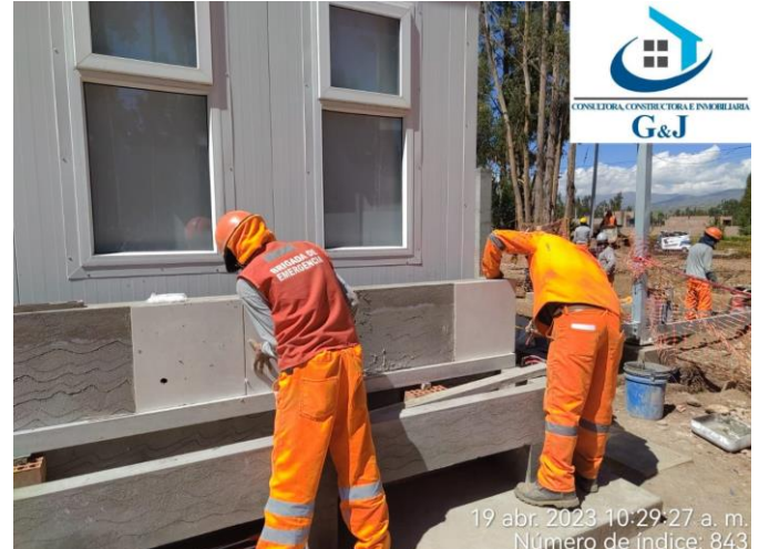
Figura 115: Se puede observar el asentado de muro de ladrillo y enchape de cerámica para los lavaderos exteriores.
