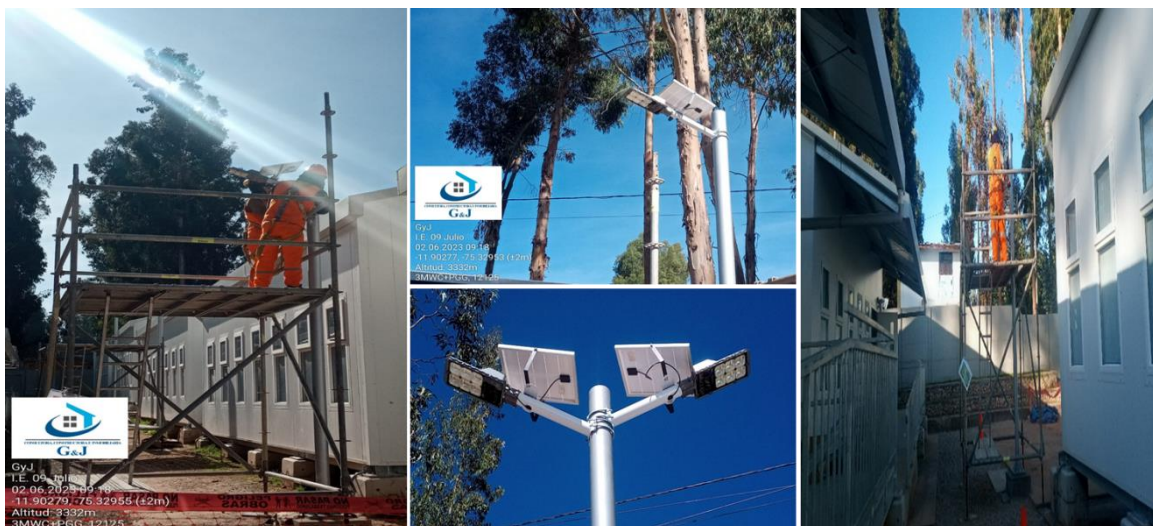
Figura 78: Instalación de luminaria fotovoltaica en exteriores.
