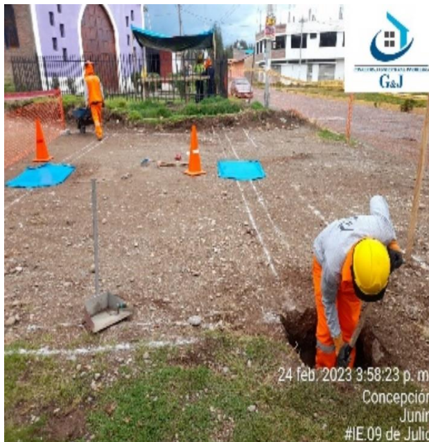
Figura 37: Excavaciones manuales en zanjas y pedestales.
