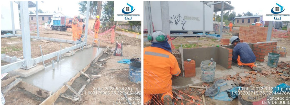
Figura 94: Construcción de muro de albañilería de lavadero.
