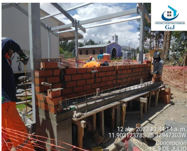
Figura 115: Se puede observar el asentado de muro de ladrillo y enchape de cerámica para los lavaderos exteriores.
