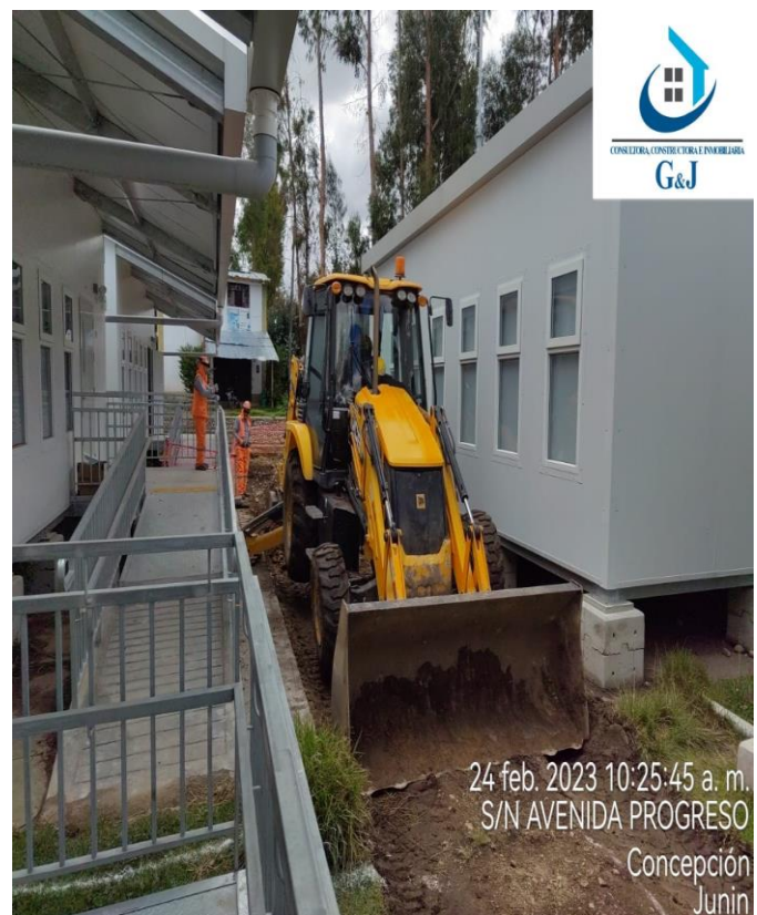
Figura 38: Excavaciones con maquinaria para las instalaciones exteriores.
