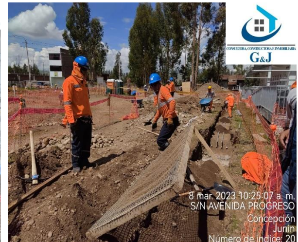
Figura 112: Se aprecia las actividades de relleno de zanjas de las instalaciones eléctricas y puesta a tierra exteriores.
