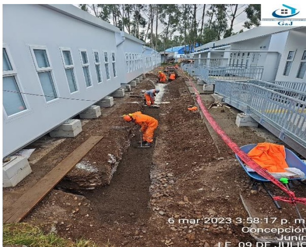
Figura 112: Se aprecia las actividades de relleno de zanjas de las instalaciones eléctricas y puesta a tierra exteriores.
