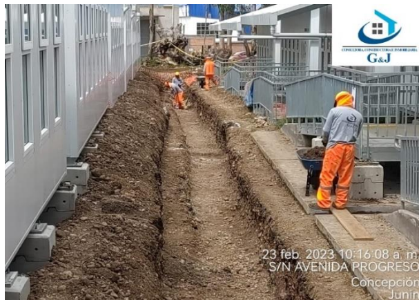
Figura 46: Relleno por capas en distintos sectores.
