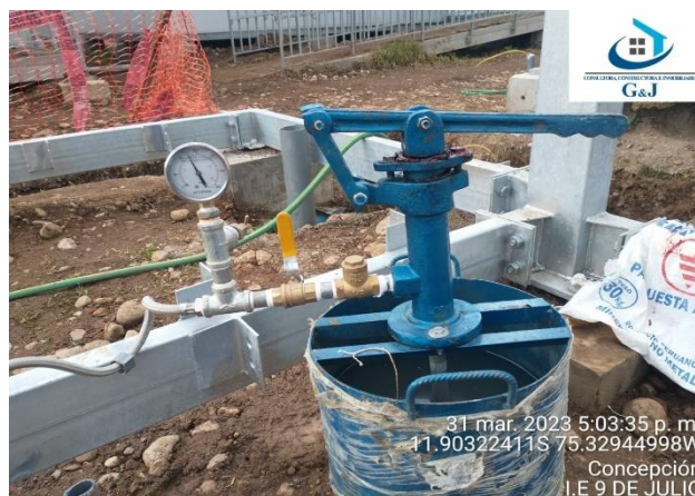
Figura 67: Inicio de prueba hidráulica.
