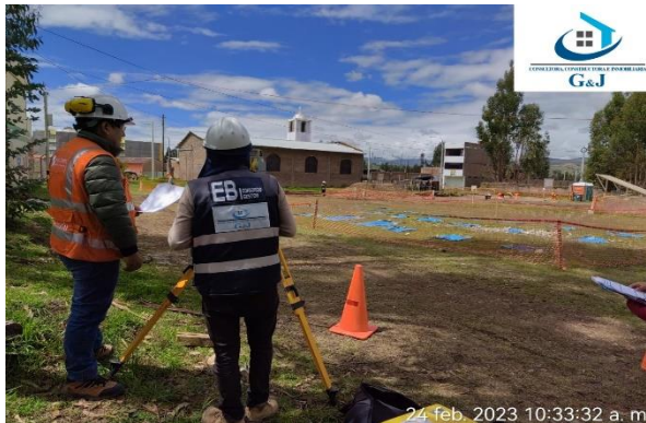
Figura 111: Para las liberaciones se realizó el respectivo trazo y replanteo con ayuda de la topografía.
