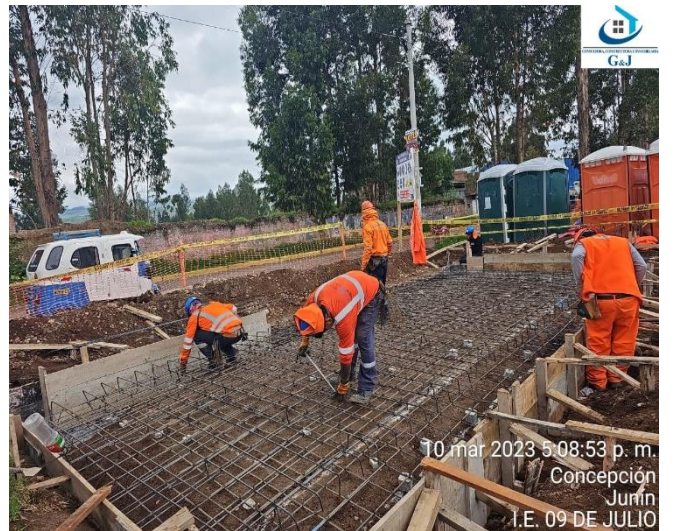
Figura 114: Se desarrolla las actividades de armado e instalación de acero para buzones y losa armada.
