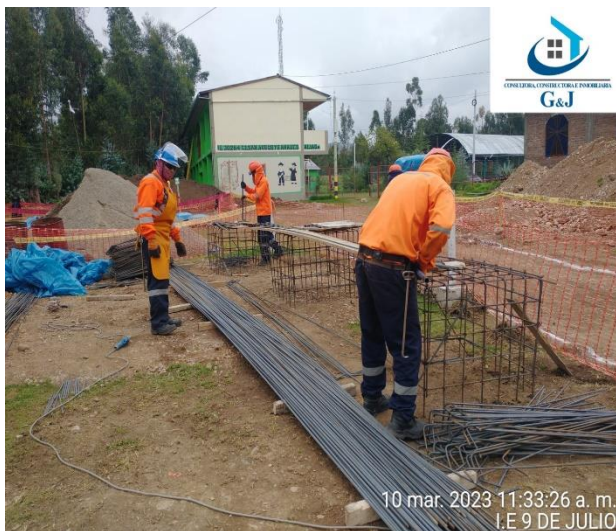
Figura 114: Se desarrolla las actividades de armado e instalación de acero para buzones y losa armada.
