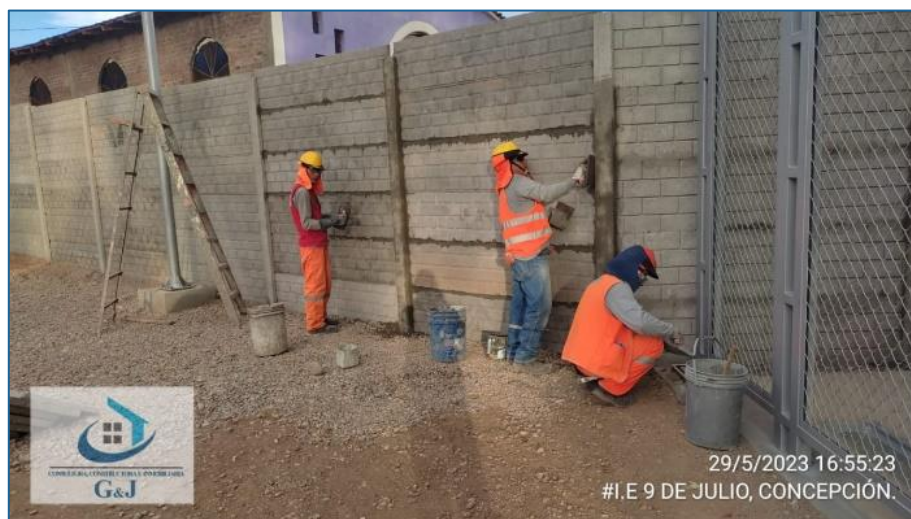
Figura 100: Solaqueo de placas y postes prefabricados.
