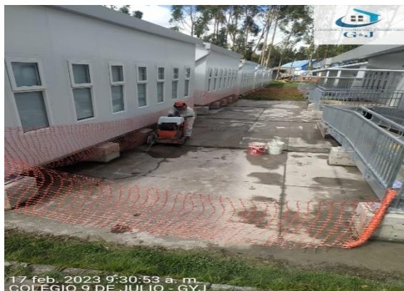
Figura 49: Demolición de losa existente.
