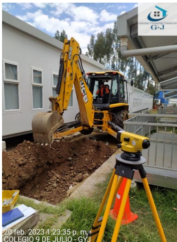
Figura 38: Excavaciones con maquinaria para las instalaciones exteriores.
