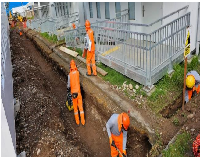
Figura 113: En la imagen se aprecia la compactación con pistón y la realización del ensayo de densidad.
