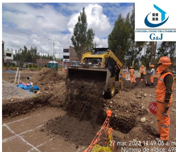
Figura 48: Relleno con material de préstamo y ensayo de densidad.
