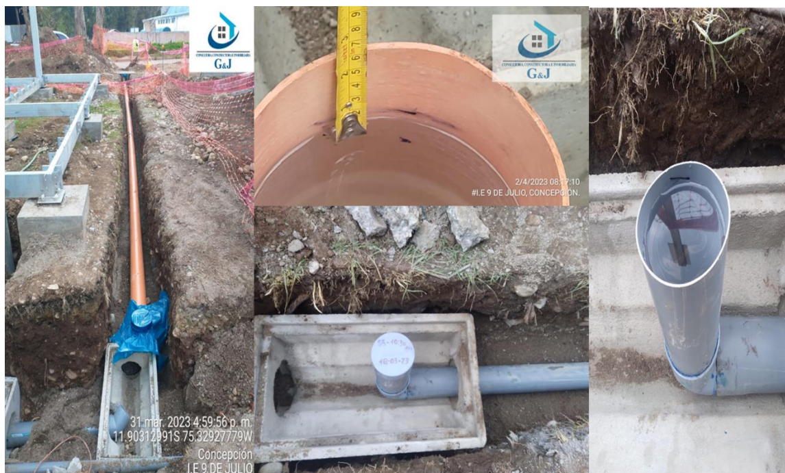
Figura 69: Prueba de estanqueidad en las redes de desagüe.
