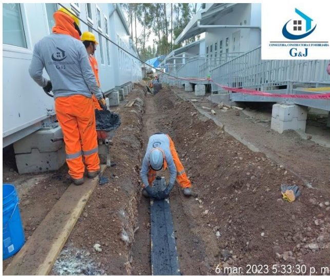
Figura 116: Se aprecia la instalación del cemento conductivo y la realización de soldadura exotérmica para el sistema de puesta a tierra exterior.
