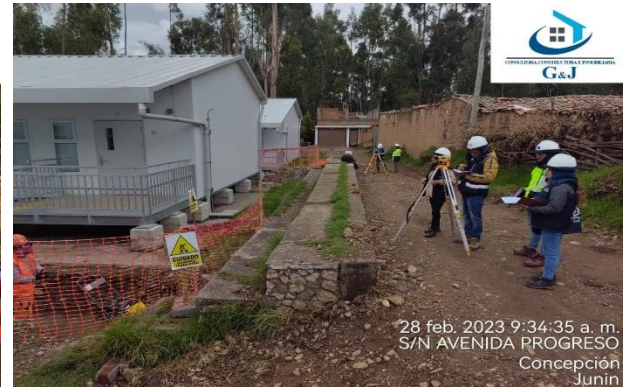
Figura 111: Para las liberaciones se realizó el respectivo trazo y replanteo con ayuda de la topografía.
