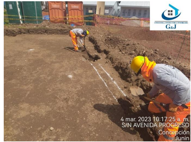
Figura 110: Se realizaron excavaciones manuales para las diferentes estructuras.
