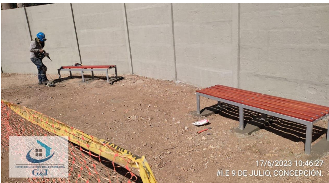
Figura 109: Instalación de bancas de madera en exteriores.
