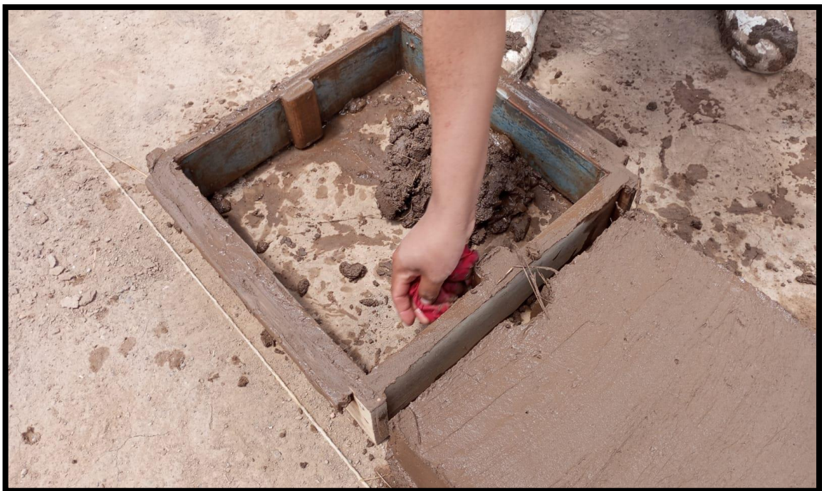
Fotografía 6: Nivelar la superficie del adobe.
