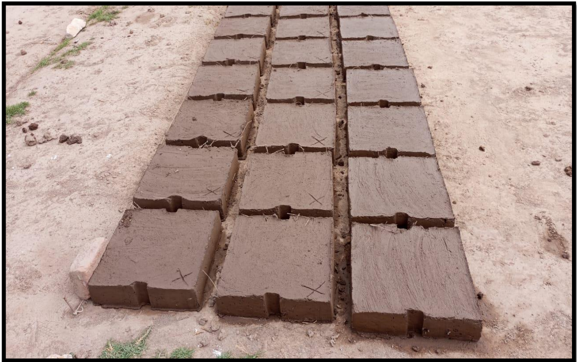
Fotografía 13: Dejar secar los adobes al aire libre en posición horizontal por 3 días en el suelo.
