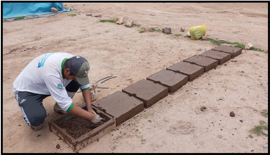
Fotografía 7: Presionar bien la mezcla del molde eliminando burbujas.
