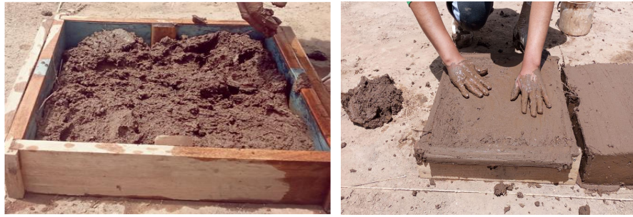
Figura 10. Llenar los moldes con tierra y nivelar la superficie.
