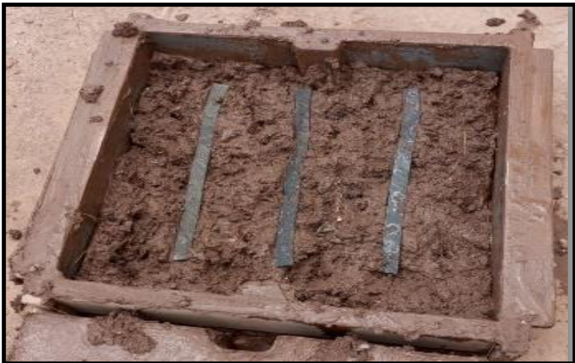
Fotografía 10: Colocación de la Primera Hilada de Tiras de Caucho al Adobe.
