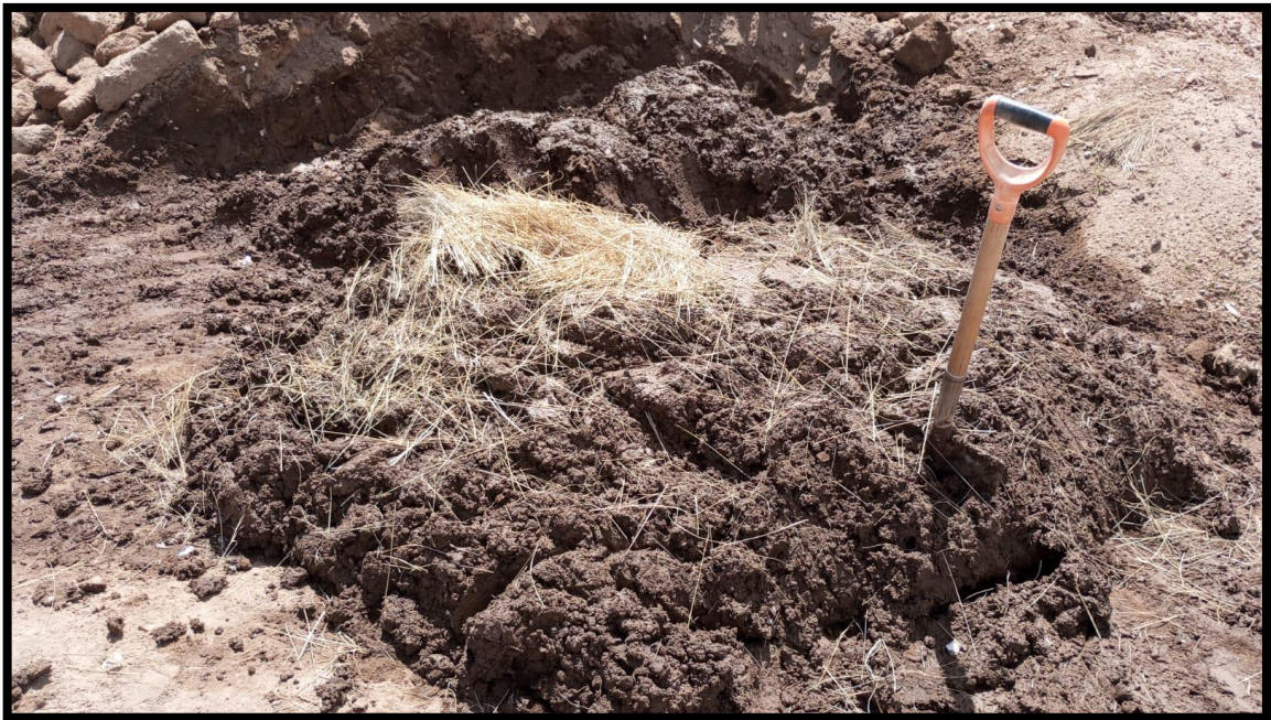
Fotografía 3: Agregar fibra vegetal para aumentar la resistencia al agrietamiento.
