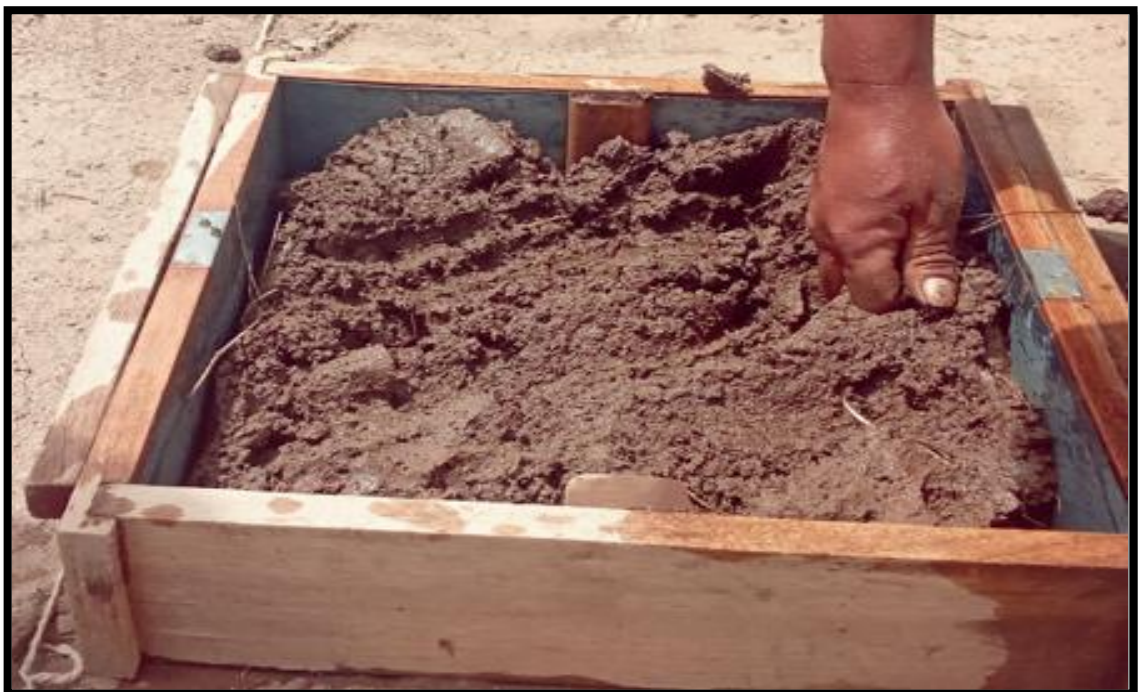
Fotografía 8: Compactar bien la mezcla de adobe para evitar espacios vacíos.
