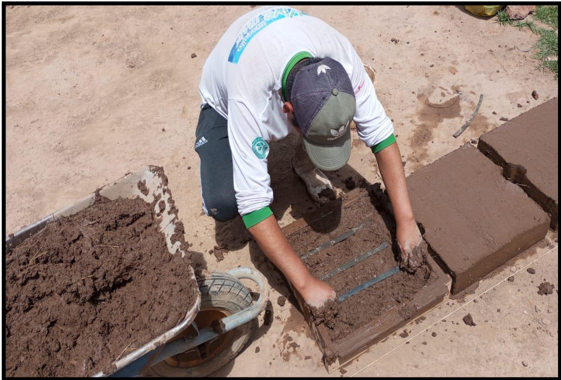
Fotografía 11: Colocación de la 2da Hilada de Tiras de Caucho al Adobe.
