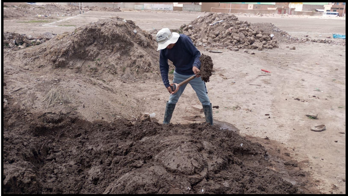
Fotografía 1: Preparacion de la mezcla de adobe para mejora la resistencia.
