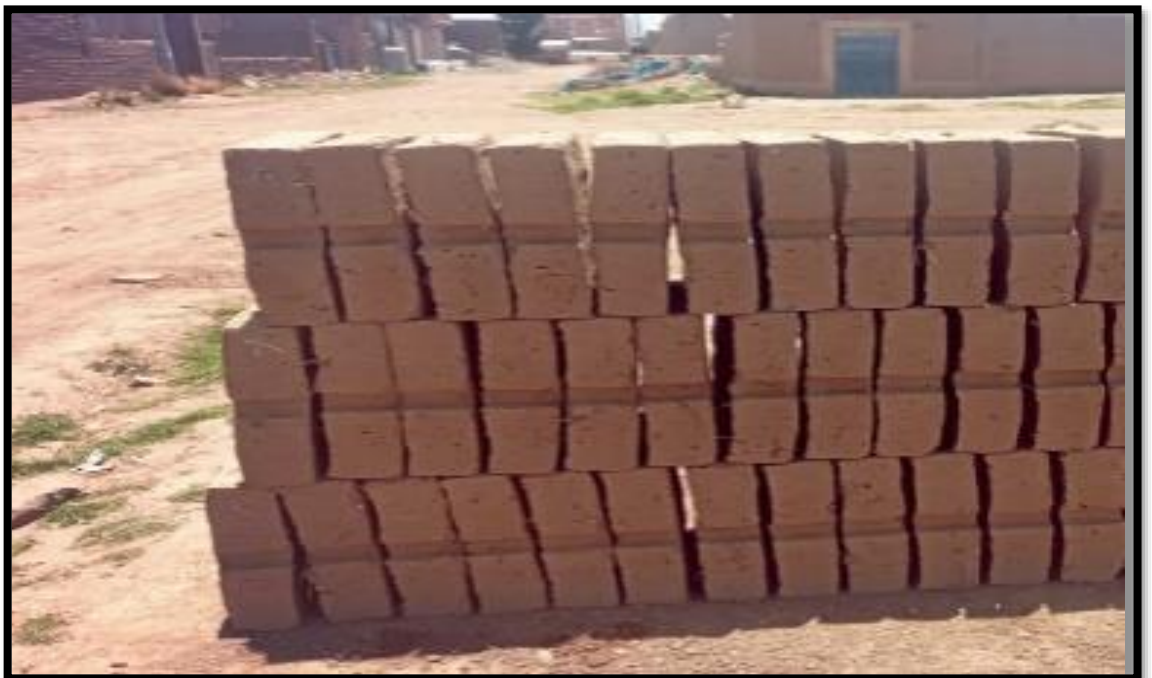
Fotografía 14: Dejar secar el adobe otros 10 días en forma vertical es importante protegerlos del sol para que no se agrieten.
