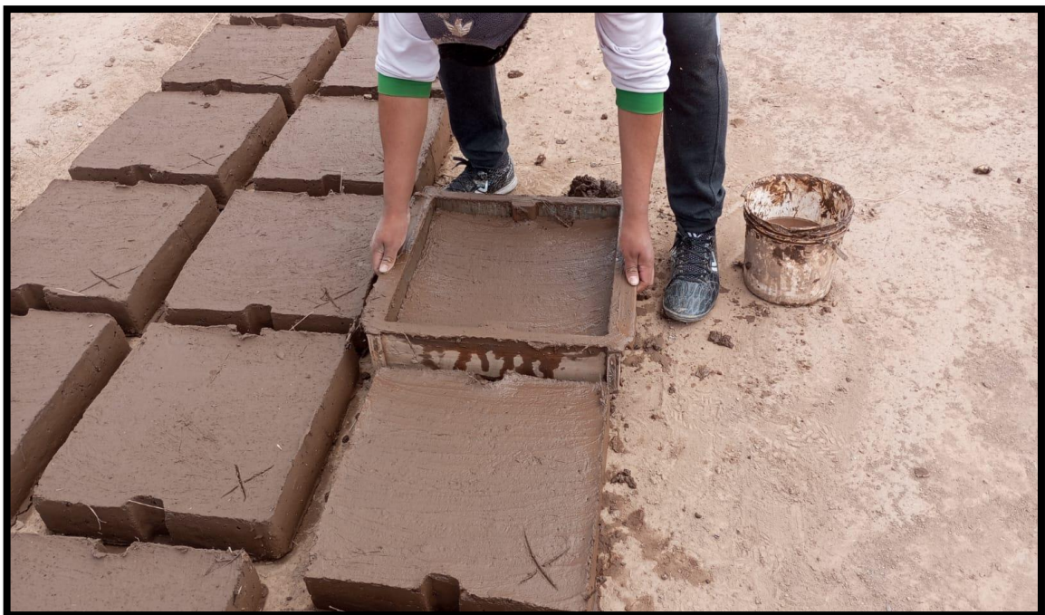
Fotografía 12: Retirar el molde cuidadosamente dejando el adobe formado sobre el suelo o sobre una base madera o plastico..
