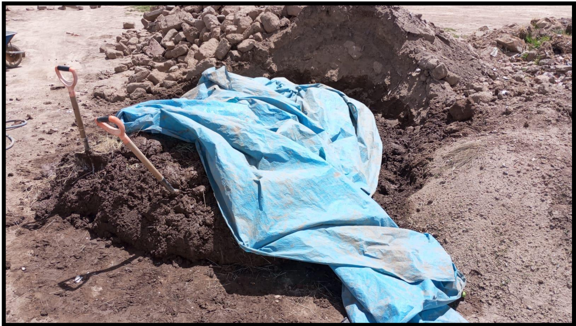
Fotografía 5: Reposar la mezcla de adobe por 2 días.
