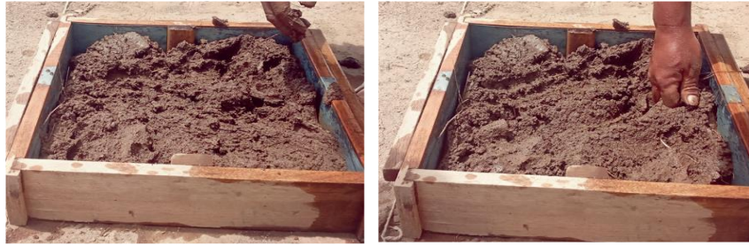
Figura 6. Llenar los moldes con la mezcla de tierra
