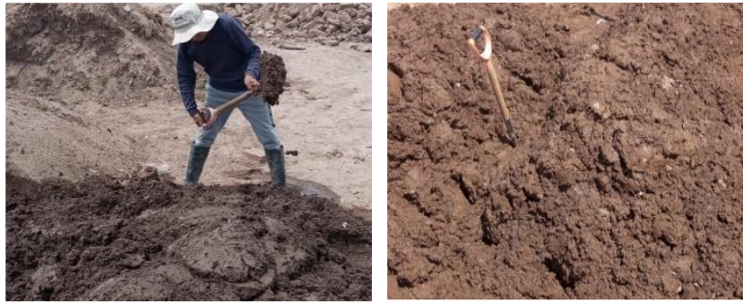
Figura 8. Preparacion de la mezcla
