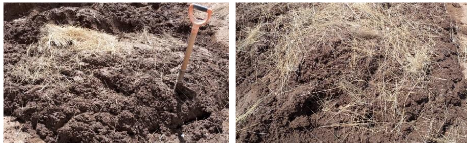
Figura 5. Preparacion de la mezcla en campo.
