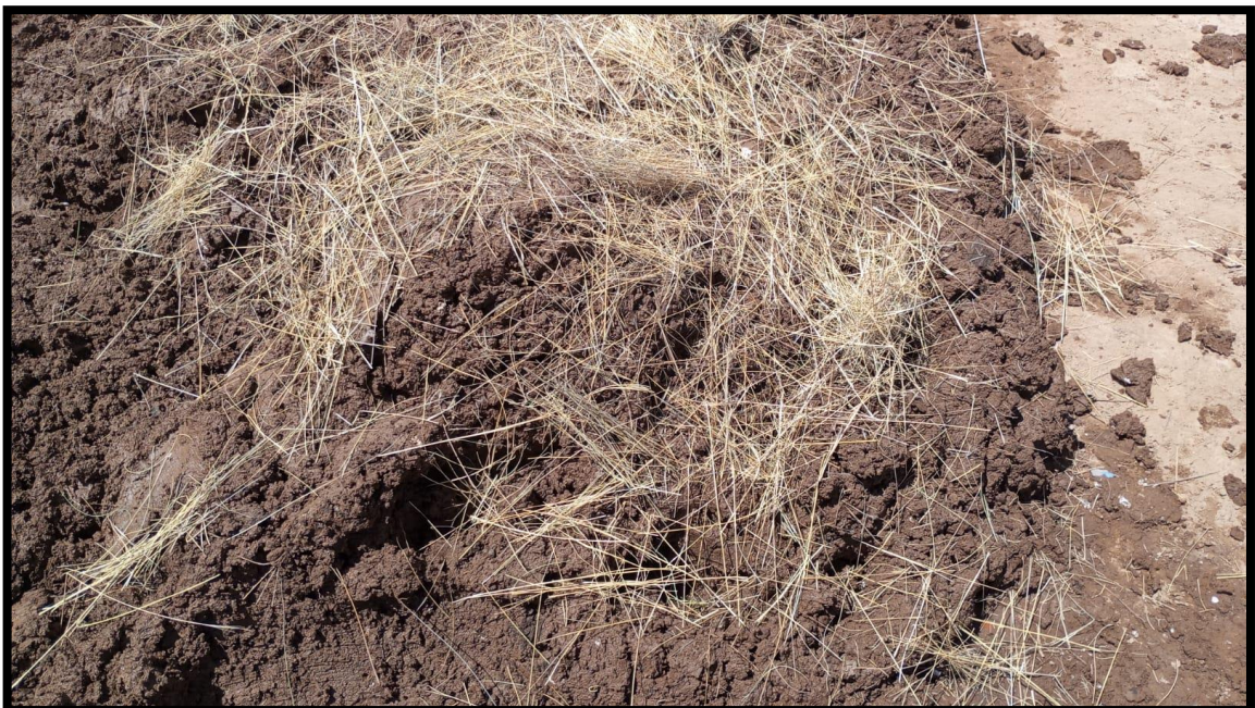
Fotografía 4: Mezclando Tierra y Paja.
