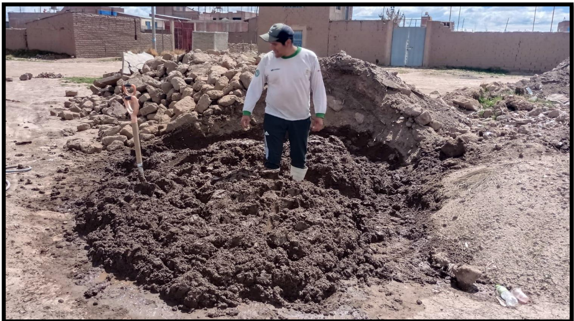
Fotografía 2: Se Agrega agua hasta obtener una masa homogénea.
