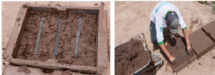
Figura 11. Añadiendo tiras de caucho a la mezcla de tierra de adobe
