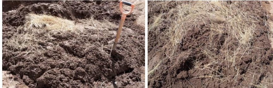
Figura 9. Preparacion de la mezcla añadiendo paja para el agrietamiento.
