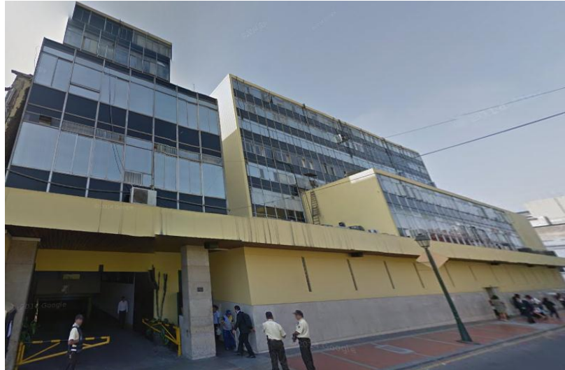
Figura 18 – Vista en elevación desde el Jr. Lampa edificio Central 1 y edificio Universal (Google maps)
