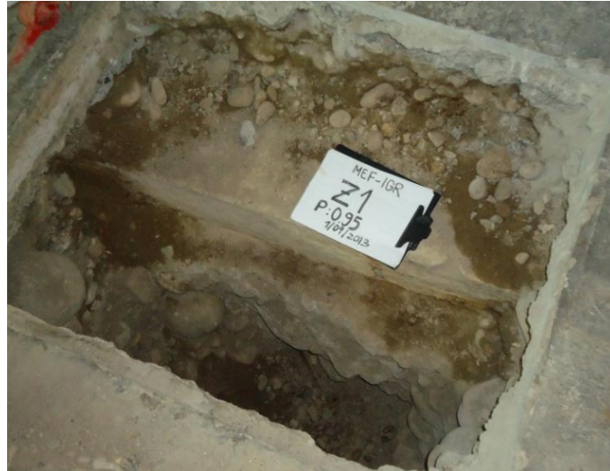
Figura 20 - Auscultación de zapata Z-1 (IGR 2013)
