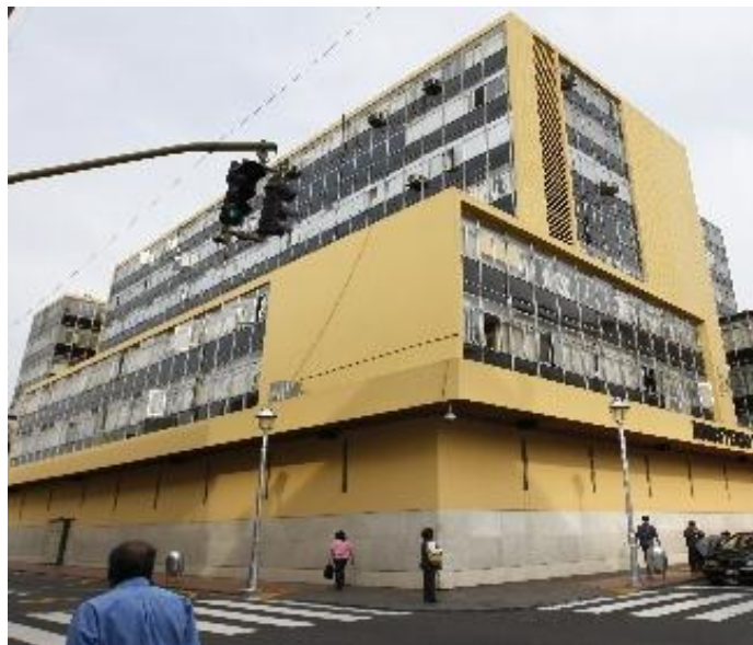
Figura 21 - Vista exterior del edificio Universal (IGR 2013)
