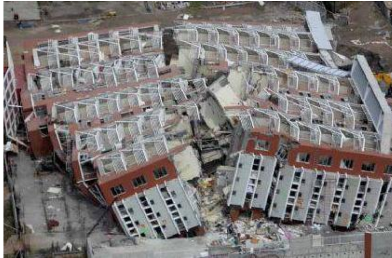
Figura 5- Colapso del edificio Alto Rio (CSN 2010)
