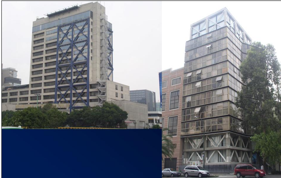
Figura 49 - Aplicación de disipadores de energía en México
