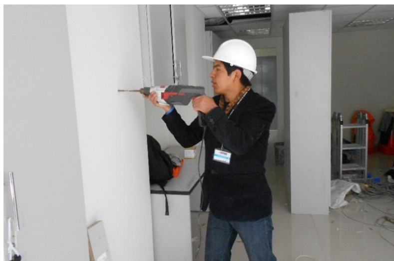
Figura 45 - Verificación de muros de ladrillos pandereta
