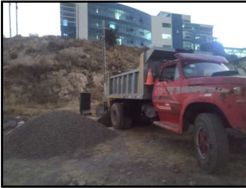
Adquisición de material de agregado grueso de la cantera Piedra Azul.
