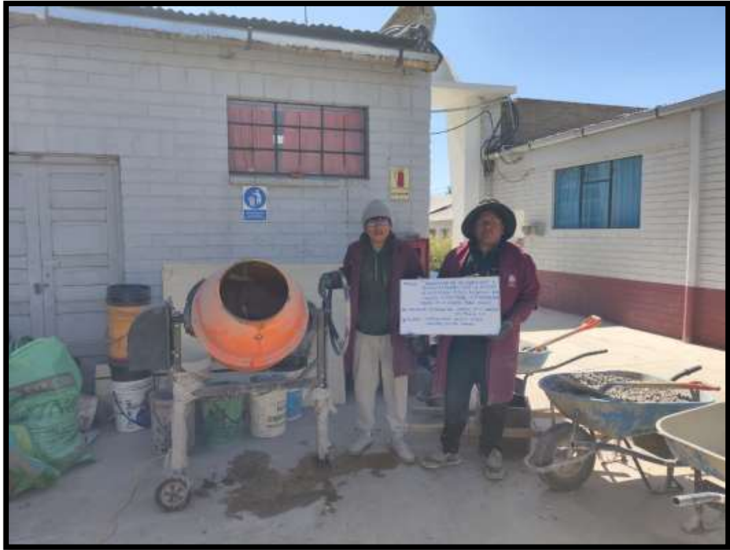
Preparación de concreto incorporando nanosílice y polvillo de horno rotax.
