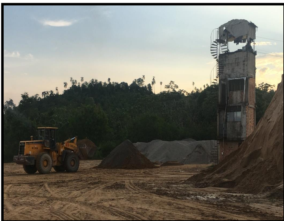
Figura 31. Panorámica de la Planta Industrial
