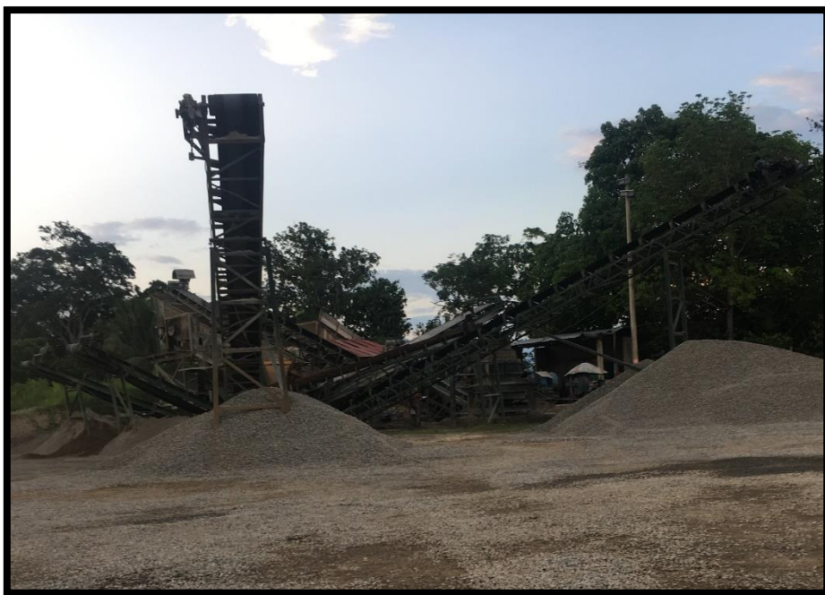
Figura 30. Panorámica de la Planta Chancadora
