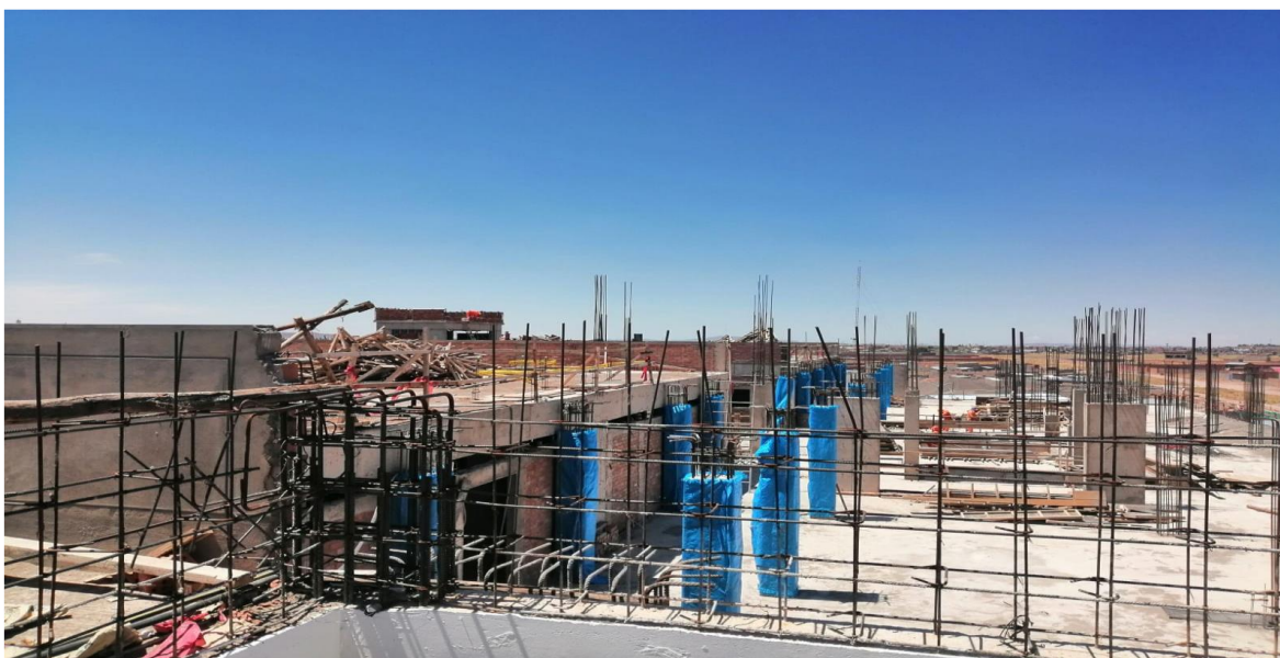
FOTO 02: SE MUESTRA LAS LOSAS TERMINADAS
