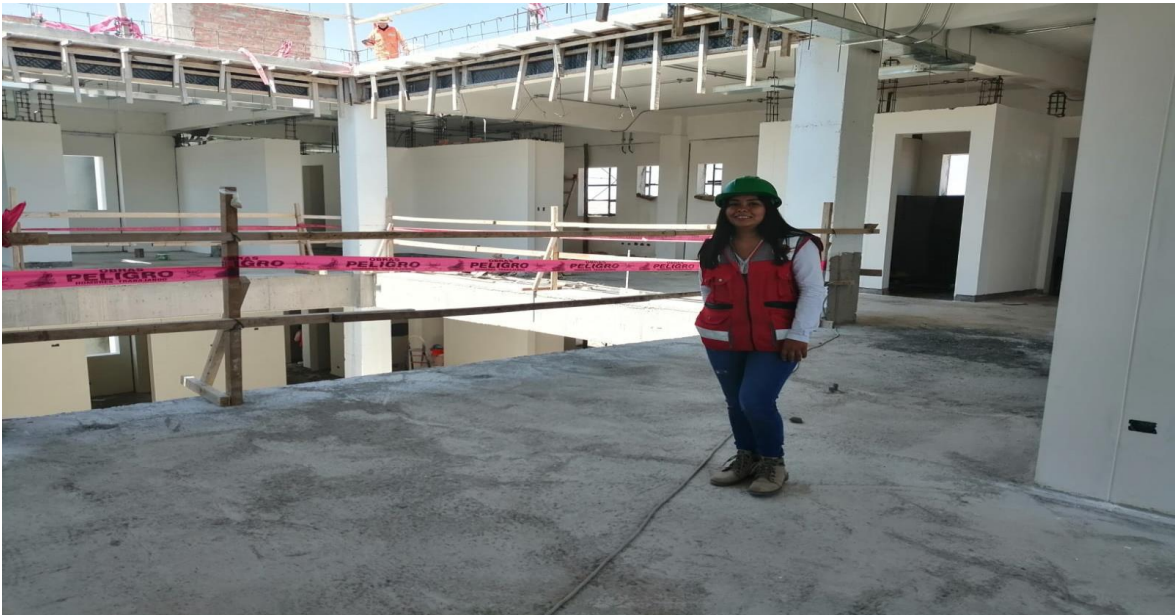
FOTO 04: VERIFICACION DE LOS TRABAJOS REALIZADOS
