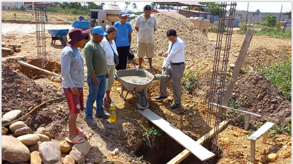
Iniciando con el encofrado de las columnas.
