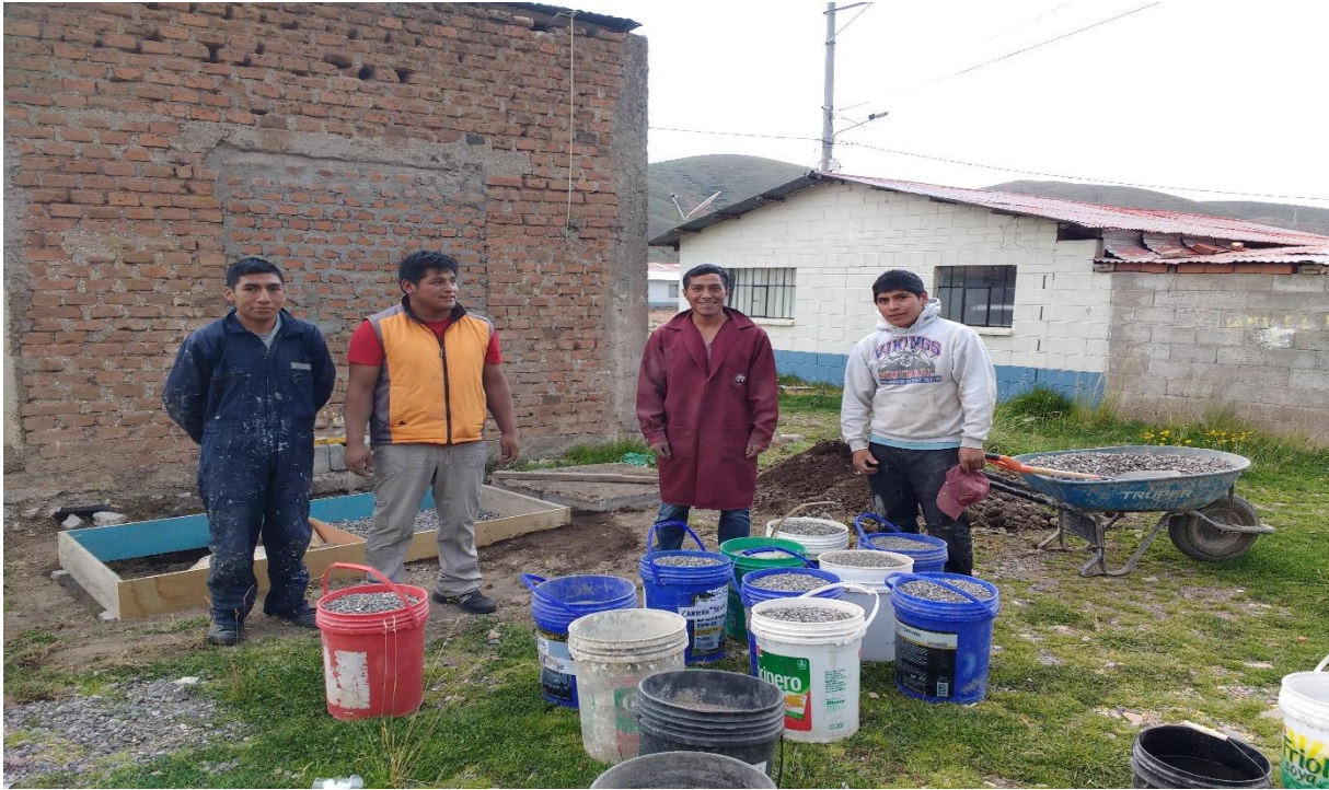
Fotografía 19. Agregados para el tramo de prueba de concreto permeable
