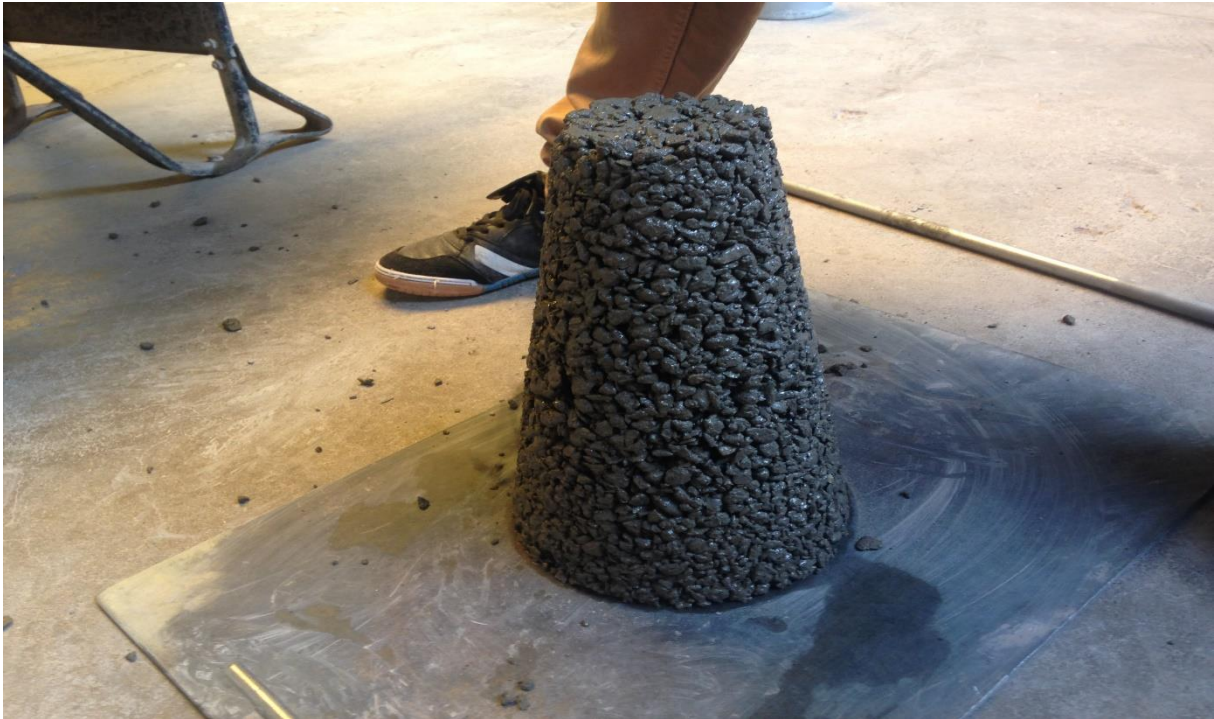
Fotografía 9. Ensayo de asentamiento en cono de abrams (0 slump)
