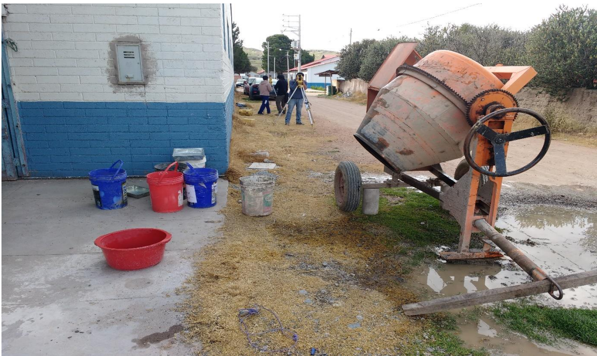
Fotografía 8. Mezcladora utilizada en la investigación
