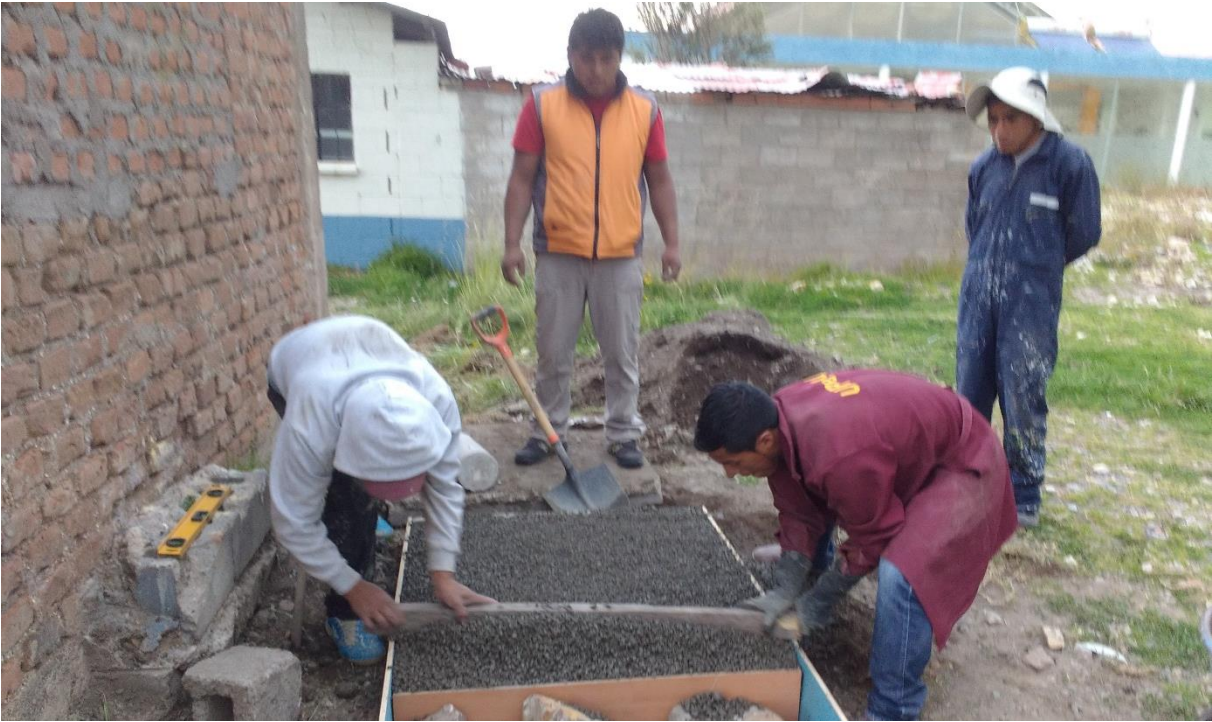
Fotografía 21. Nivelado de la mezcla de concreto permeable
