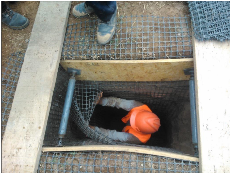
Figura 82: Entibado de calicatas
