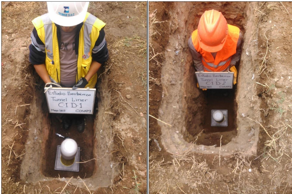
Figura 80: Ensayo de densidad de campo
