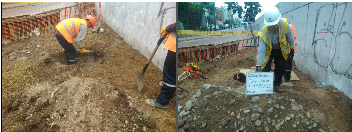
Figura 28: Inicio de excavación de calicatas y toma de muestras
