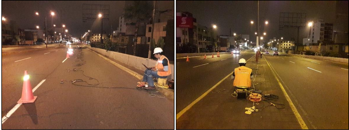
Figura 32: Ensayo de refracción sísmica y MASW
