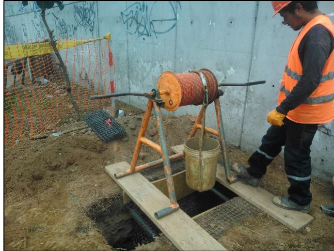
Figura 29: Excavación y extracción de muestras
