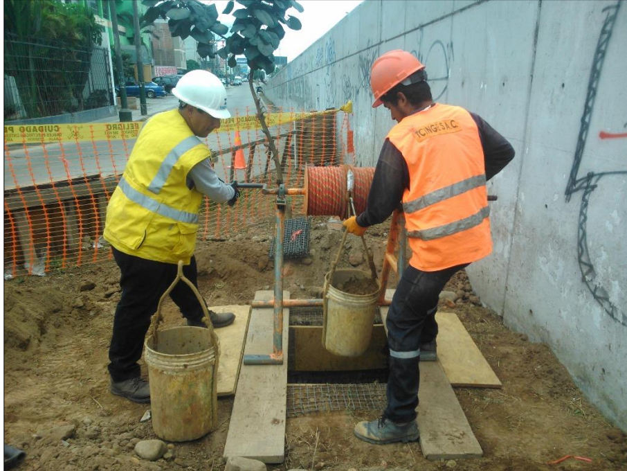
Figura 81: Excavación de calicatas
