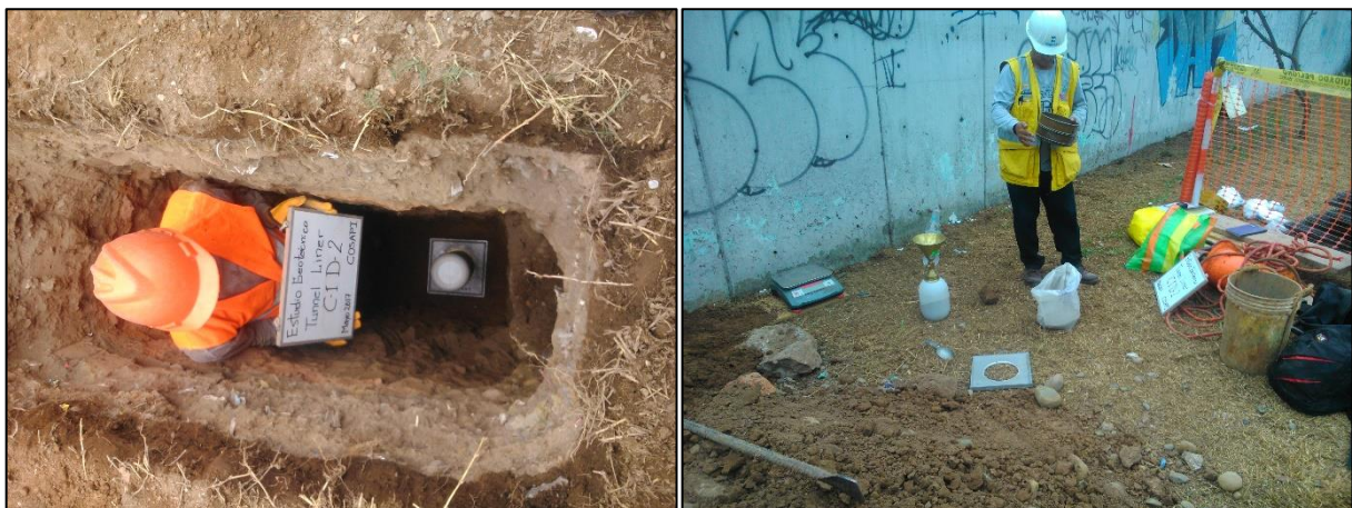
Figura 30: Ensayo de densidad de campo
