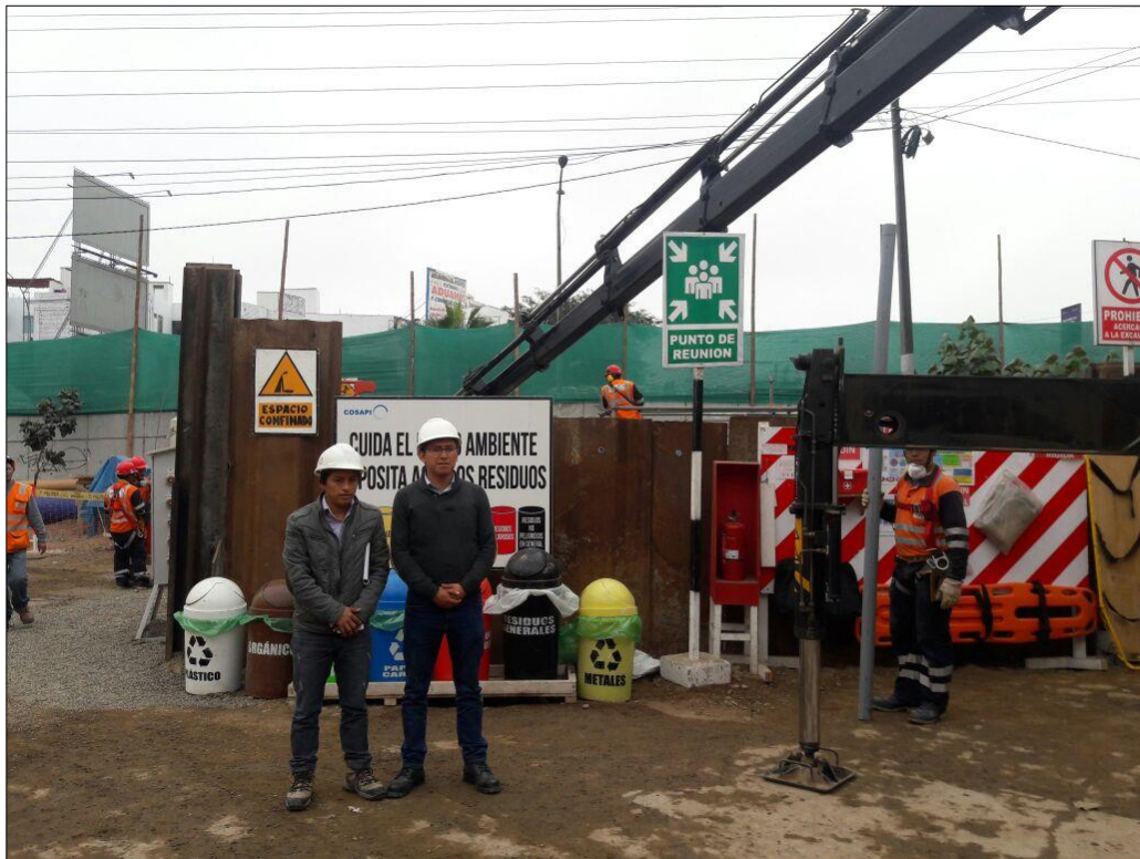
Figura 88: Tesistas durante el inicio de ejecución de obra.
