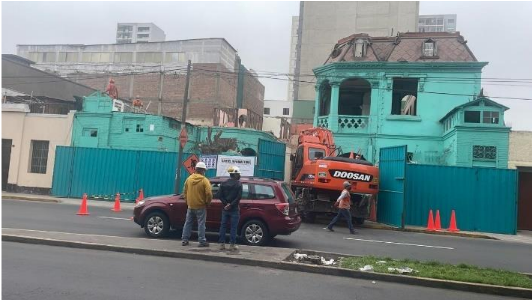
Figura 5 Demolición mecánica Proyecto Aurora Park, emisiones de polvo.
