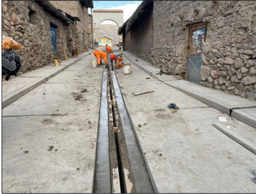
Figura N° 29 Trabajos de Concreto en Canaleta calle San Martín. Fuente: Elaboración propia.
