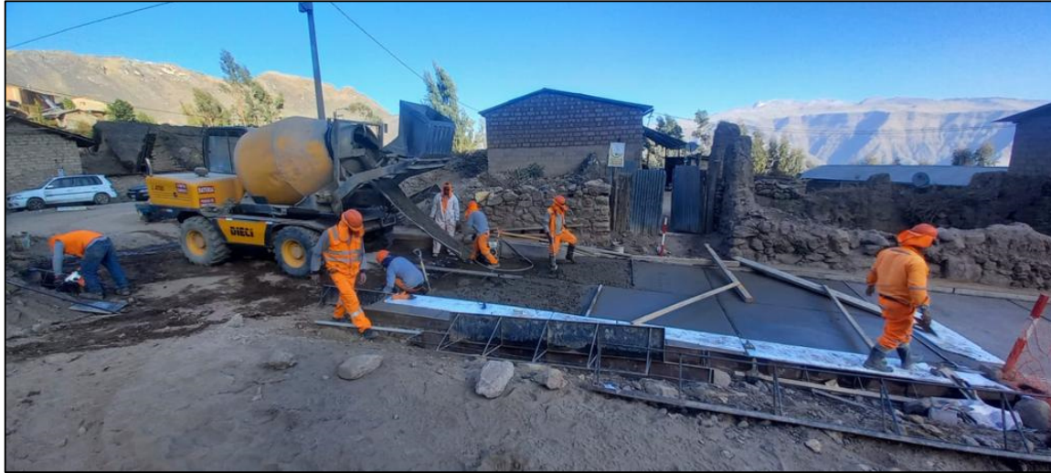
Figura N° 28 Vaciado de Concreto para pavimento en calle Arequipa. Fuente: Elaboración propia.
