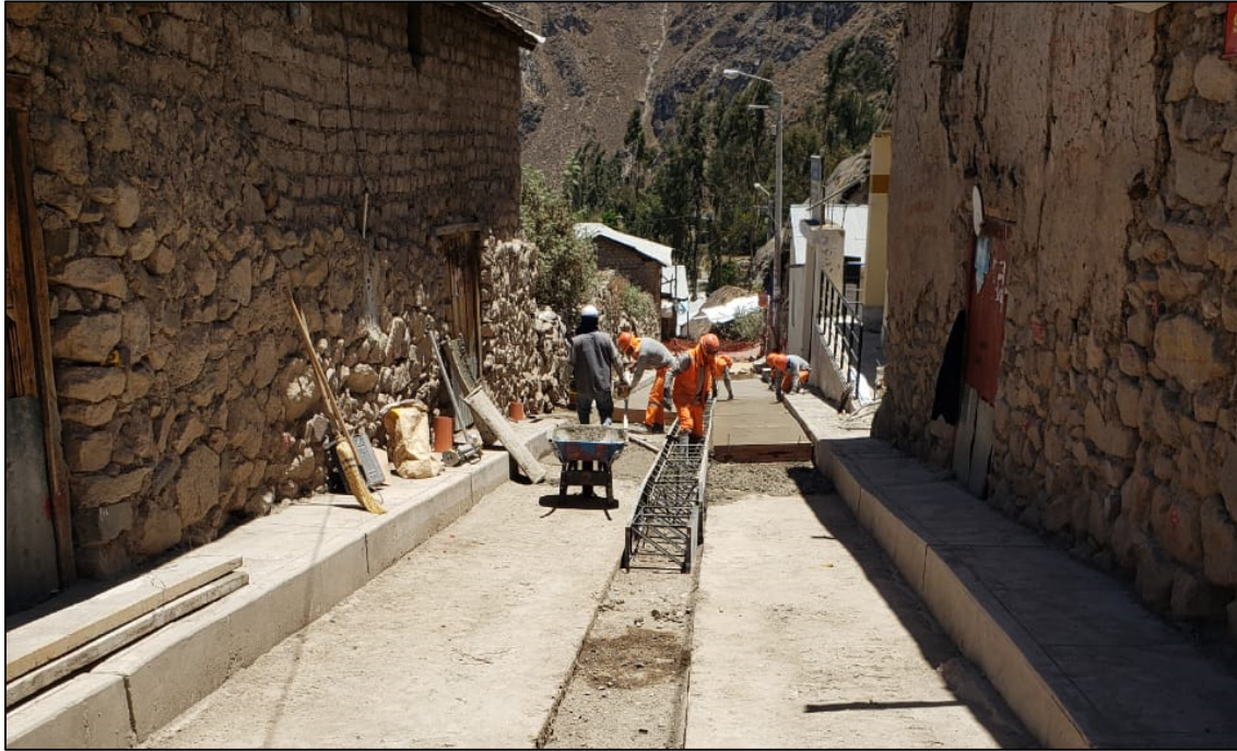
Figura N° 30 Trabajos en calle Manco Cápac. Fuente: Elaboración propia.
