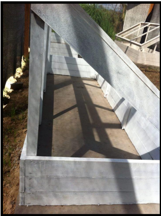
Anexo 2. Instalación de las cámaras de propagación
