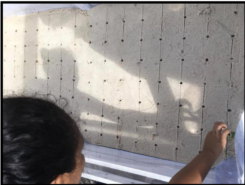
Anexo 9. Instalación de estaquillas
