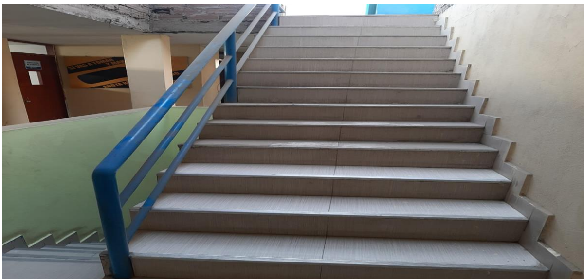
Figura C 13. Escaleras del tercer al cuarto piso de la IEP Alfonso Ugarte – Huaycán, 2021.
