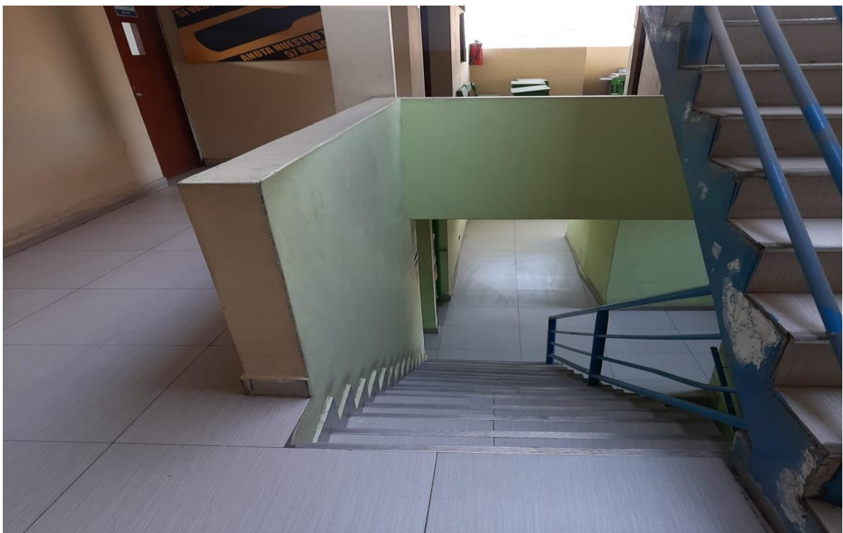
Figura C 12. Escaleras del segundo al tercer piso de la IEP Alfonso Ugarte – Huaycán, 2021.
