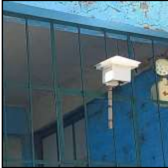
(A) INSTALACION DEL EQUIPO
