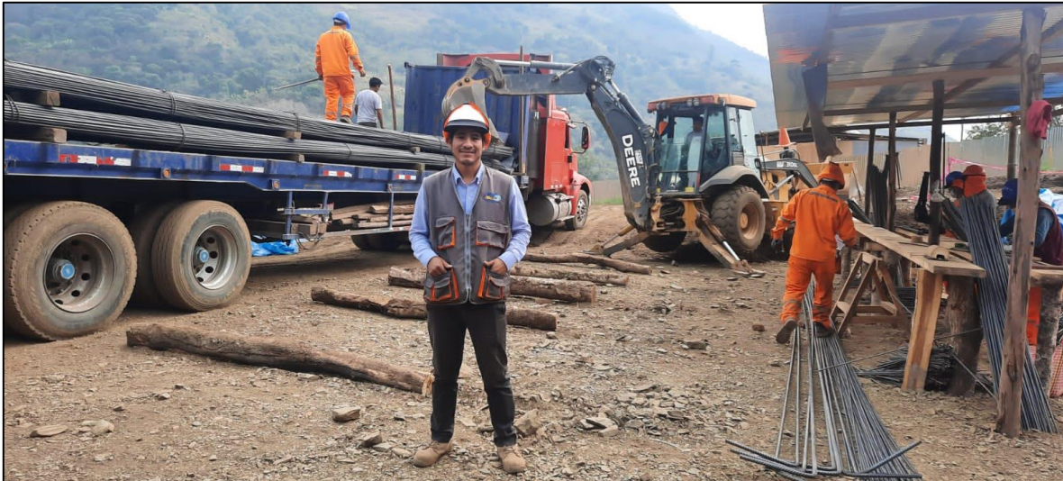
Figura 24: Banco de Aceros en la Obra. Fuente: Elaboración Propia
