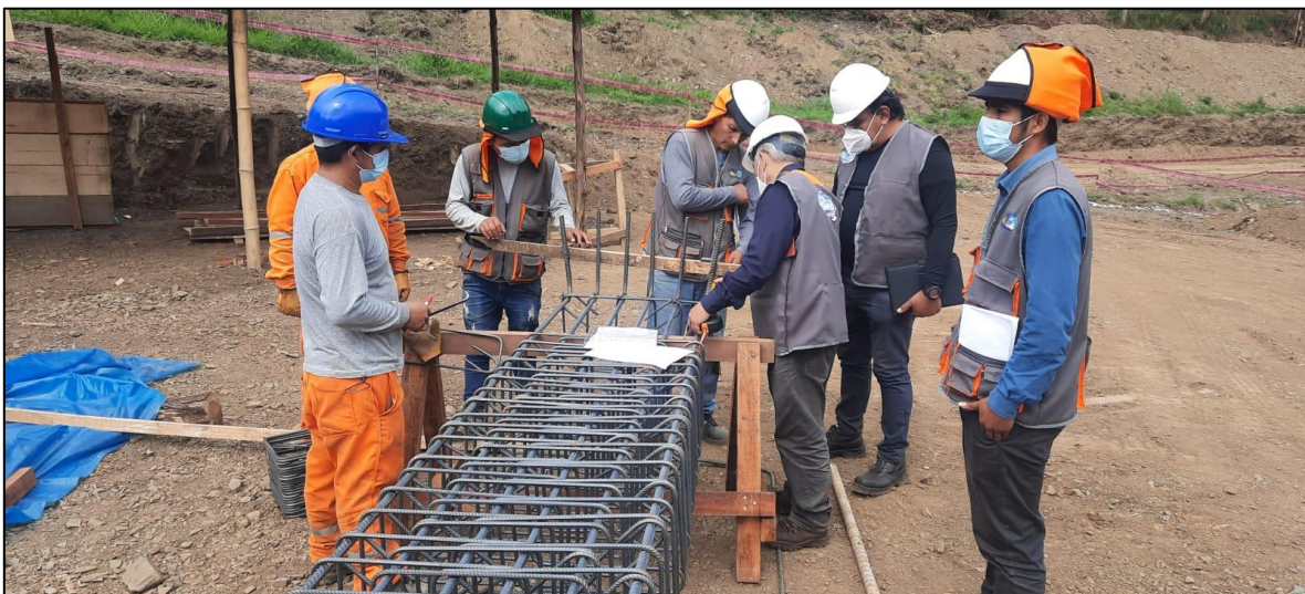
Figura 25: Protocolos de calidad de Armado de Acero. Fuente: Elaboración Propia
