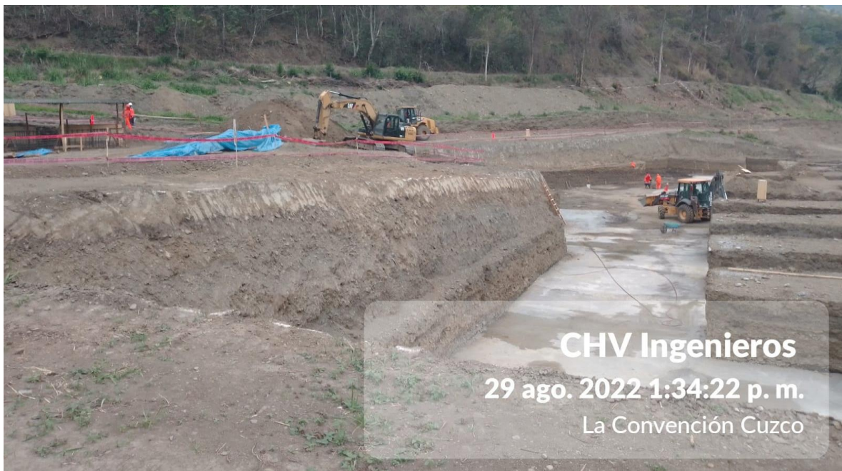
Figura 23: Comprende solados de E=4". Fuente: Elaboración Propia
