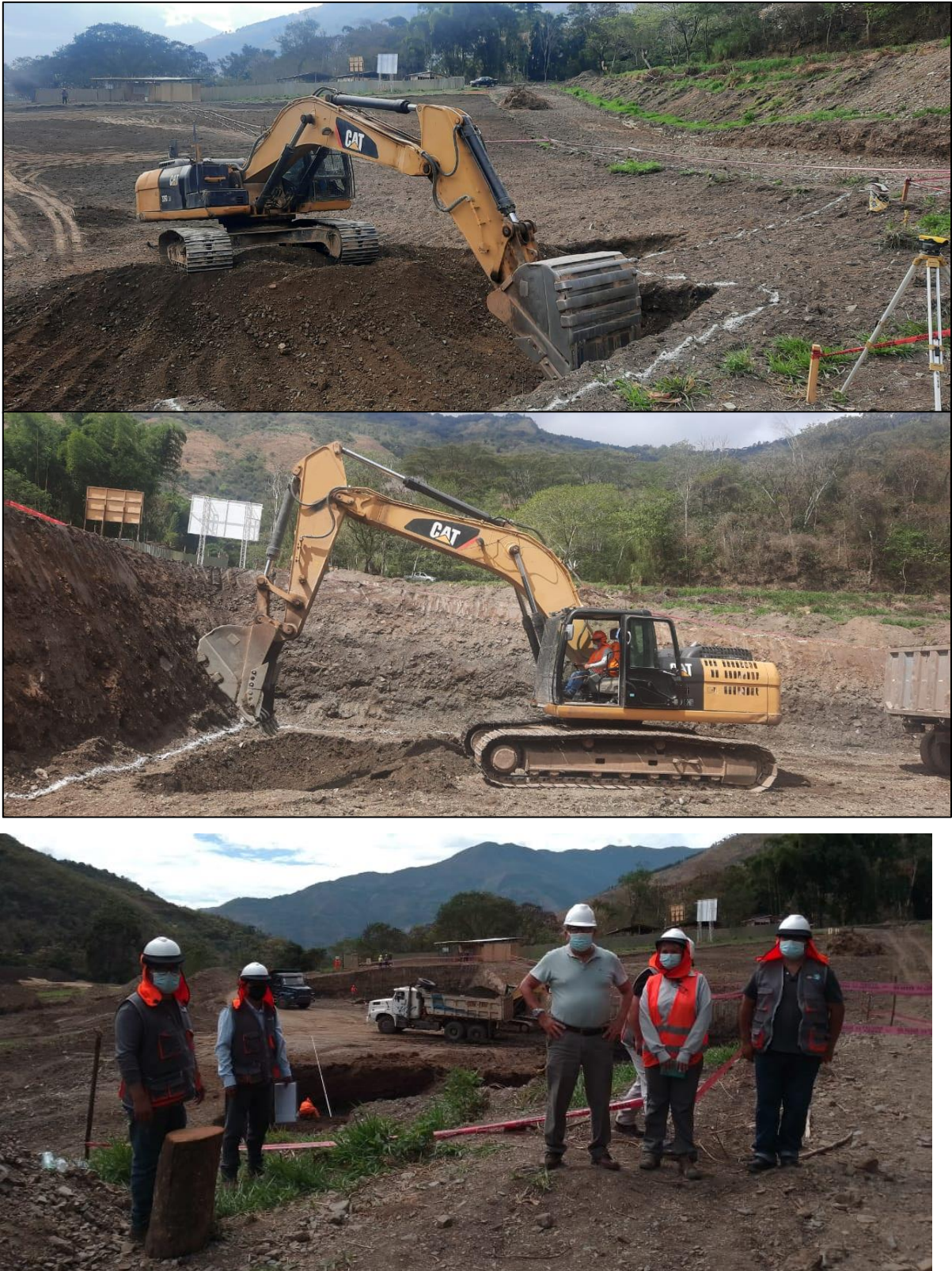
Figura 22: Inicio de Excavación masiva. Fuente: Elaboración propia
