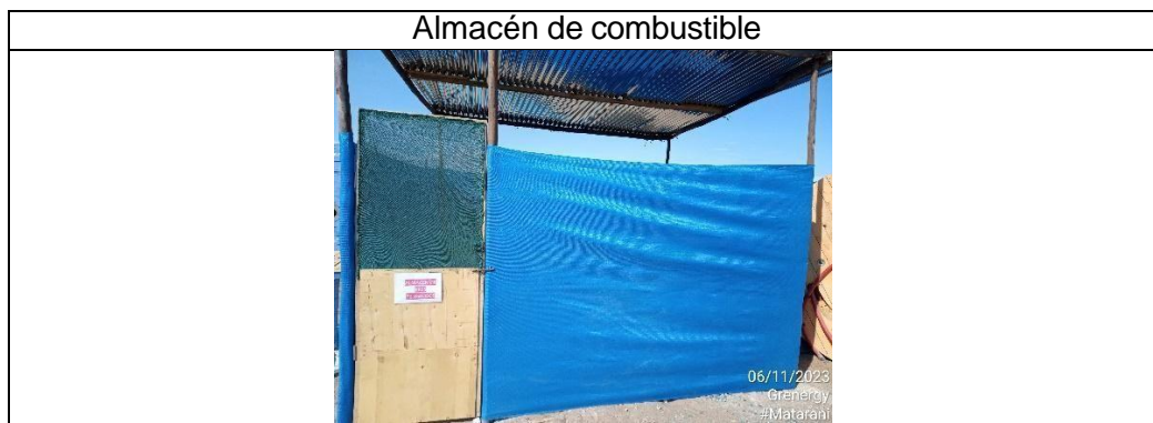
Imagen 4. Almacenamiento de combustible
