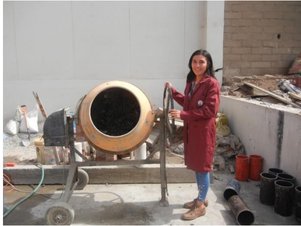
Figura 37. Elaboración del concreto permeable.
