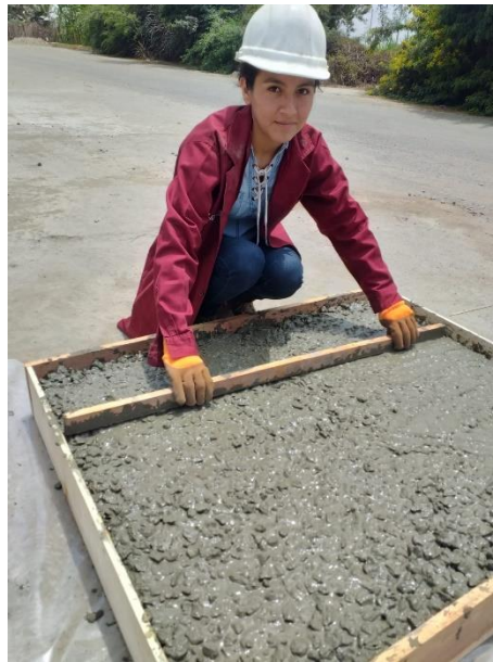
Figura 47. Nivelado de la mezcla de concreto permeable en el tramo de prueba.
