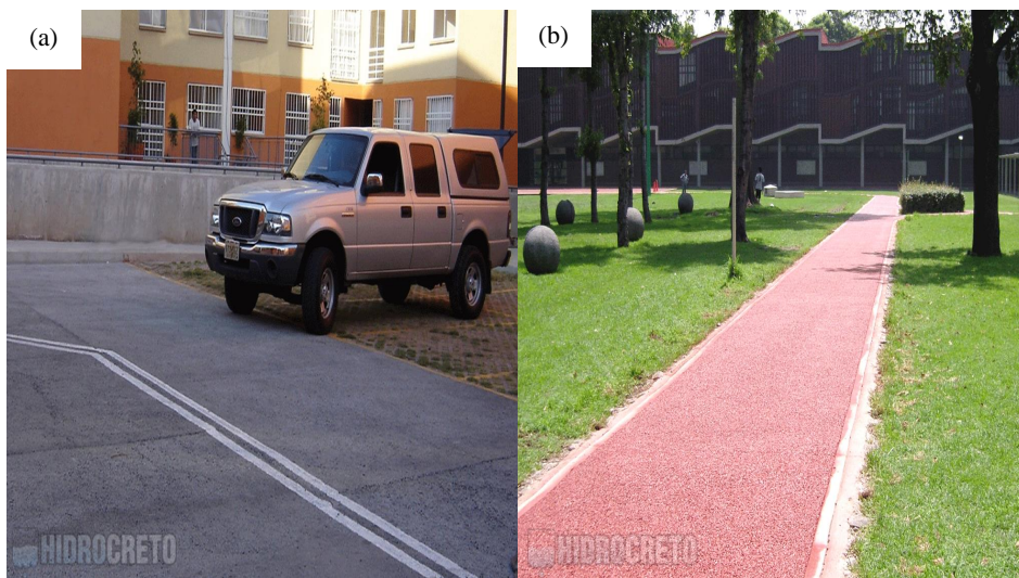
Figura 17. Aplicaciones del concreto permeable: (a) áreas de estacionamientos; (b) ciclistas y áreas verdes (Hidrocreto, http://hidrocreto.com/aplicaciones.php?idioma=es# ).
