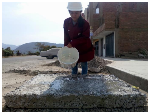
Figura 48. Ensayo de permeabilidad en el tramo de prueba
