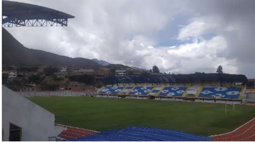
Fig. 10. Fotografía real de la obra.
