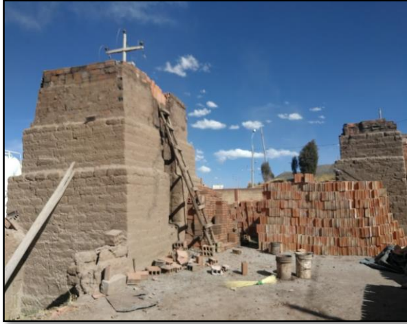
Figura B-4: Horno de la ladrillera de S. Arequipa. Fuente: Elaboración propia.
