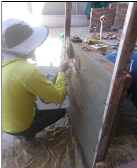
Figura 3.29. Tarrajeo de los muros c/s geomalla.
