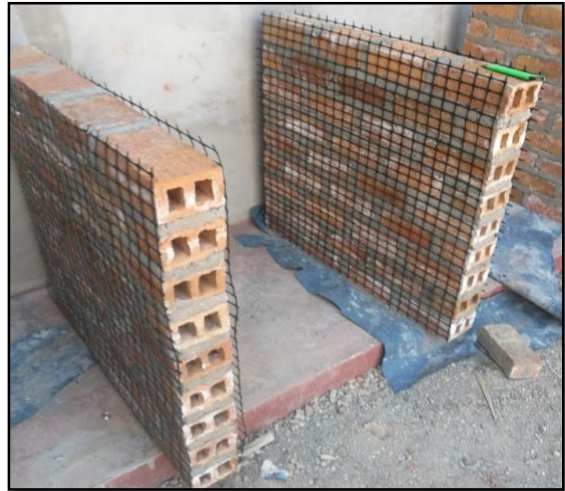
Figura B-38: Colocado de las geomallas a los muros. Fuente: Elaboración propia.
