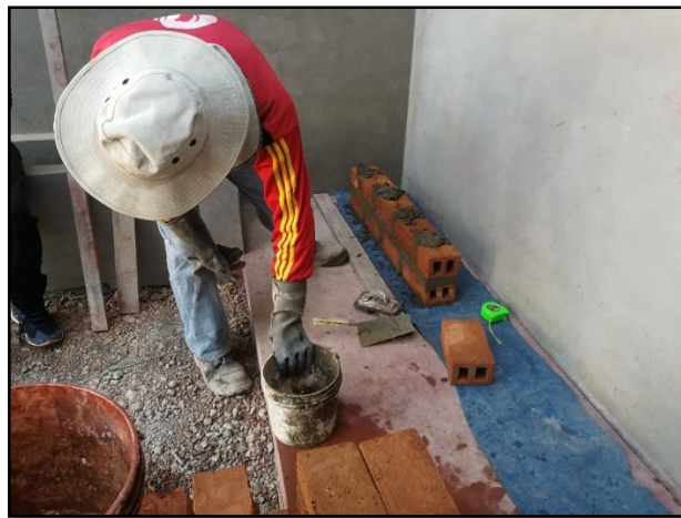
Figura 3.26. Asentado de los muros Fuente: Elaboración Propia.
