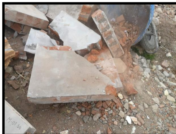
Figura 3.48. Muros después del ensayo de compresión diagonal Fuente: Elaboración Propia.
