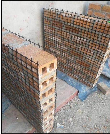
Figura 3.28. Se colocó la geomalla a los muros para mejorar su resistencia.
