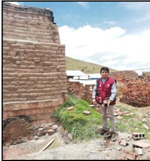
Figura 3.10. Visita a la ladrillera artesanal salida Arequipa. Fuente: Elaboración Propia.
