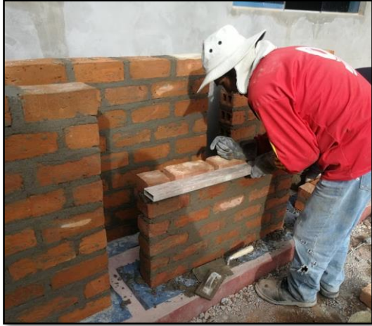
Figura B-37: Levantamiento de los muros (mano de obra calificada). Fuente: Elaboración propia.
