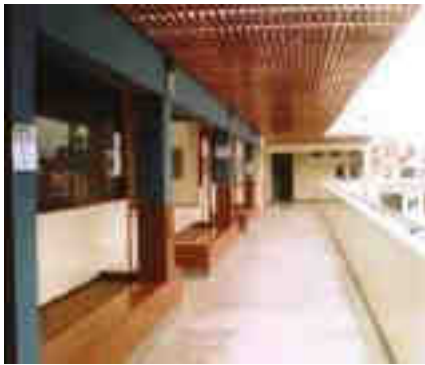
Pasillo de segundo nivel con columnas sobresalidas
