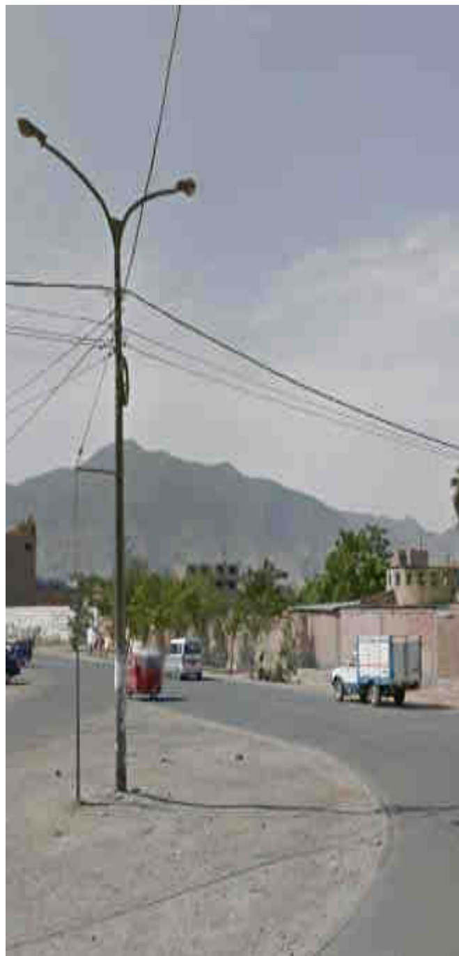
Figura 74. Fotografía del exterior del terreno, tomada desde la Av. Los Ciruelos.
