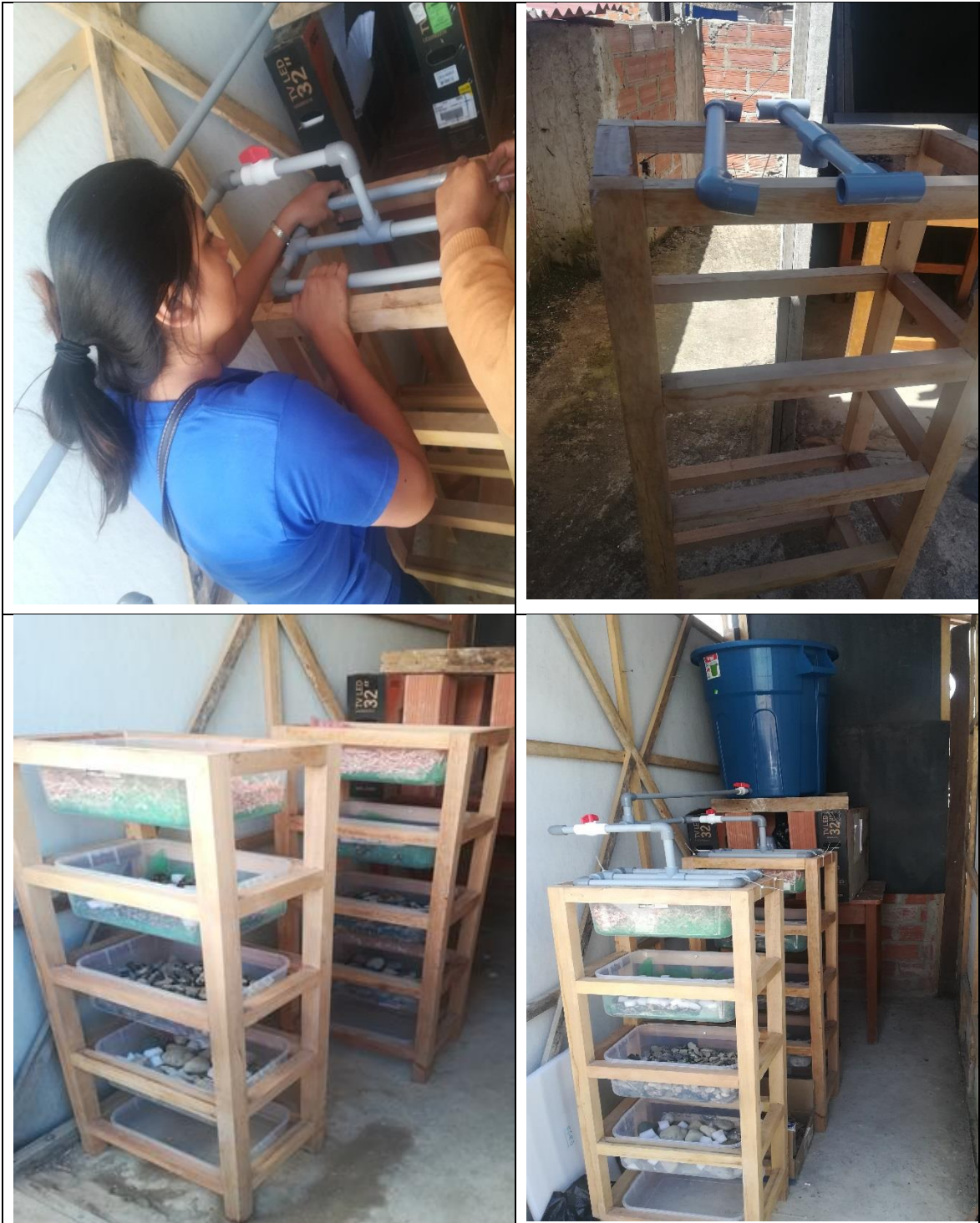
Figura 44. Proceso de construcción del tratamiento mediante lombrifiltro
