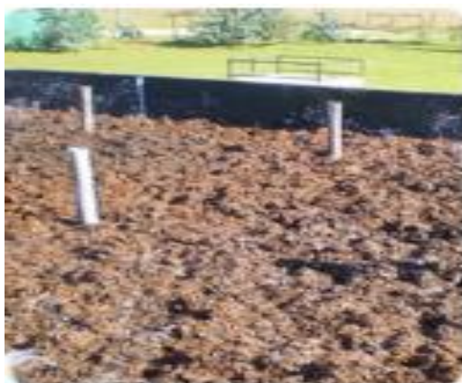
Figura 15. Aplicación de las tuberías para la aeración (Tapia & Baraña, 2004)
