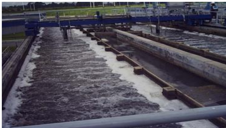
Figura 6. Desarenadores (Metcalf & Eddy, 2003).
