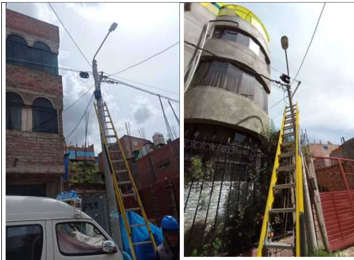
Figura 2. Trabajo de tendido aéreo de fibra óptica
